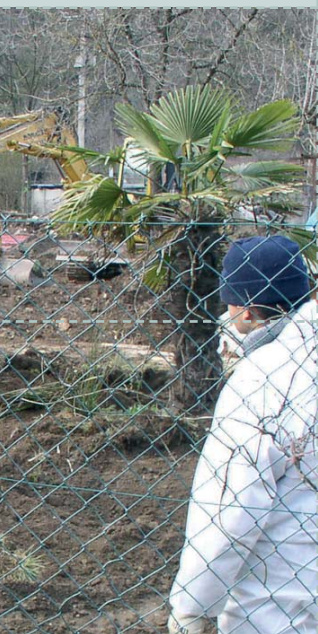
SLM pendant travaux dépollution Diren.LR©
