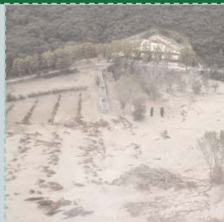
Pont du Gard, rive droite 2004-Diren©
