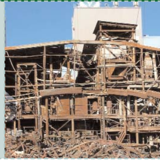
Chantier démolition SBM Diren©
