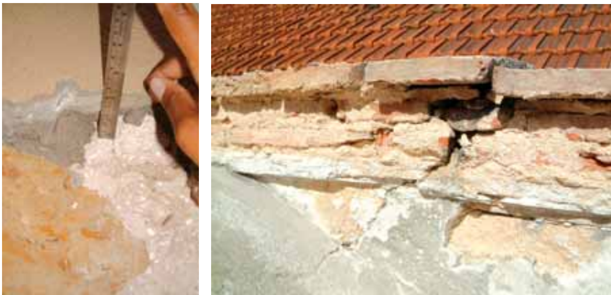
Fig. 18 – Exemplos de intervenções em revestimentos com recurso pontual a argamassas com ligantes cimentícios.
