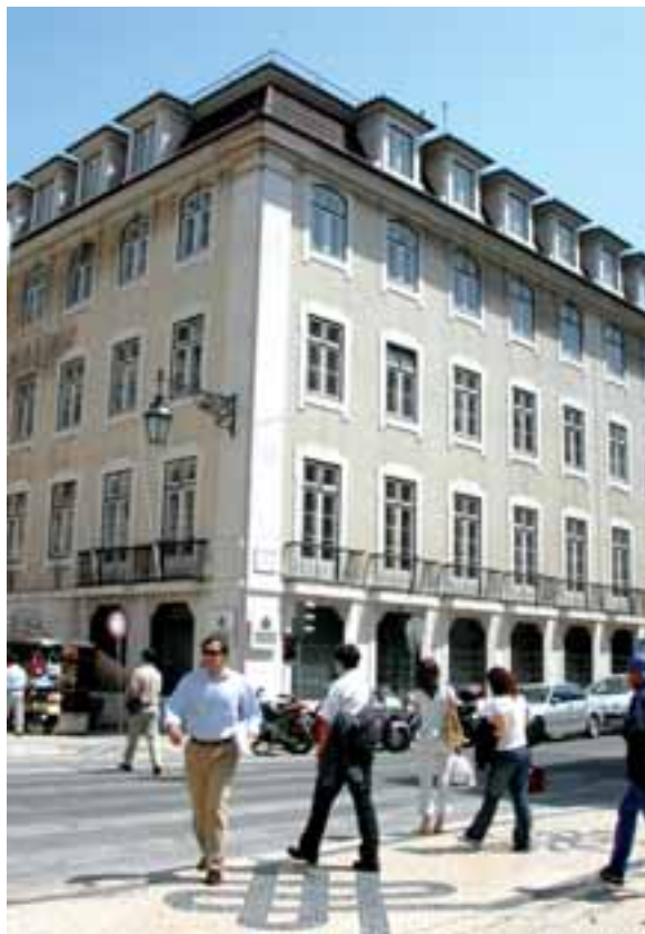
Fig. 20 – Rua Augusta, 24-32 Exemplo de edifício com fachada neopombalina.
