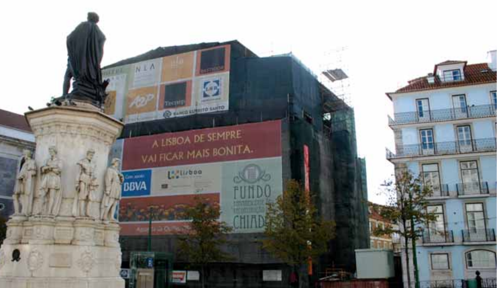
Fig. 11 – Hotel Poeta, no Chiado, em obra de reabilitação.
