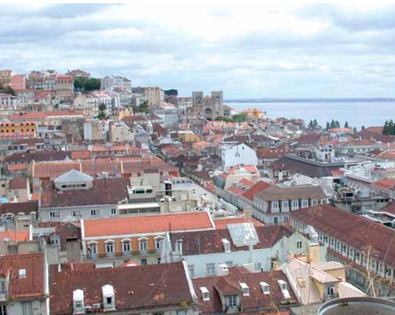
Fig. 12 – Perspectiva da 5ª fachada, zona da Rua da Conceição.
