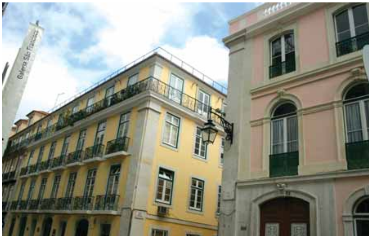
Fig. 10 – Edifício reabilitado na Rua Ivens, 35 a 43 e pormenor da fachada do Grémio Literário.
