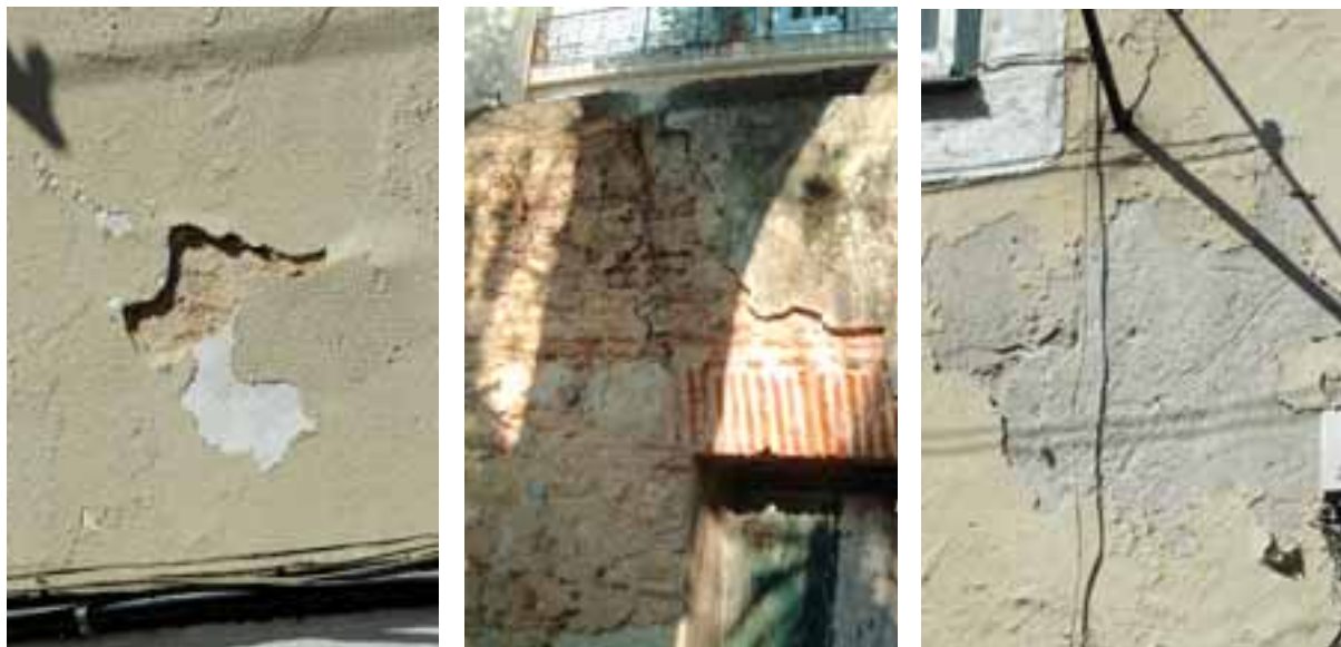
Fig. 17 – Exemplos de intervenções em revestimentos com recurso pontual a argamassas com ligantes cimentícios.
