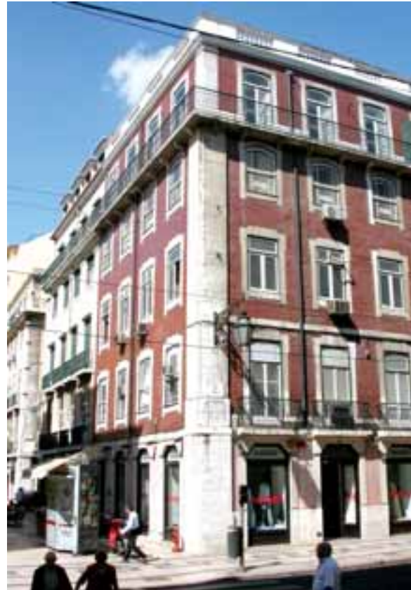
Fig. 17 – Rua da Assunção 34-40/Rua da Prata, 209-219. Exemplo de edifício de fachada pombalina, cobertura e escada gaioleira.
