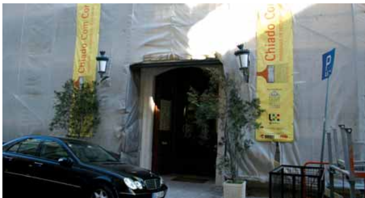
Fig. 3 – Grémio Literário, Rua Ivens, 37, durante as obras de reabilitação.
