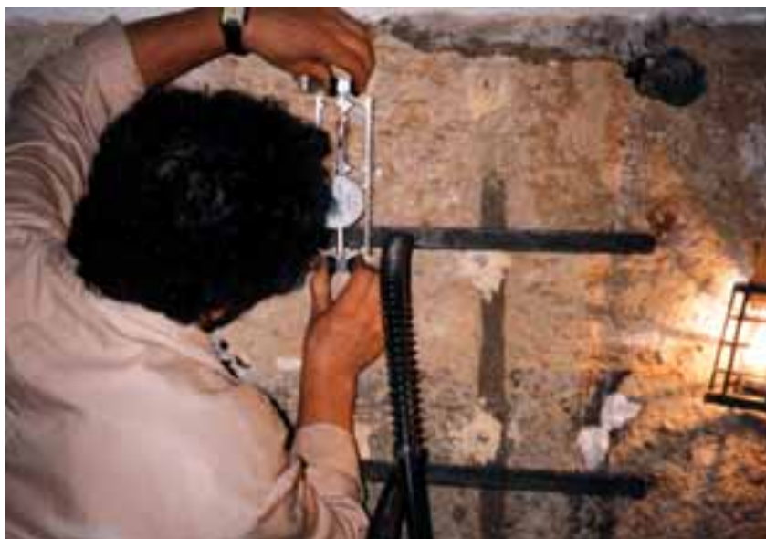
Fig. 5 – Edifício da Baixa Pombalina.
