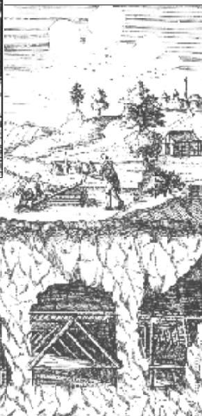
Рис. 2.5. Дерев'яне рамне кріплення штолень XVI ст. (за Агріколою)
