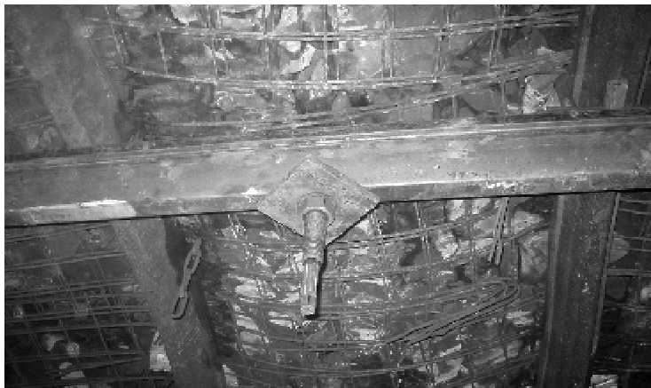
Рис. 8.6. Підсилення рам поздовжніми балками з канатними анкерами
