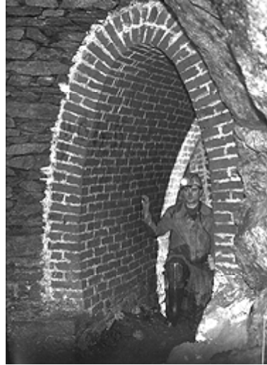
Рис. 3.5. Цегляне кріплення параболічної форми (Бранд-Ербісдорф, Німеччина)
