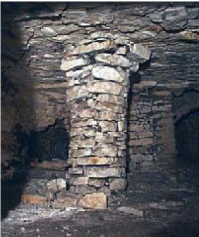
Рис. 3.1. Кам'яне кріплення у вигляді стовпчастої конструкції (неолітична копальня кременю у Кшемьонках, Польща)
