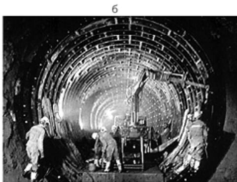
Рис. 5.12. Монтаж тюбінгового кріплення:
