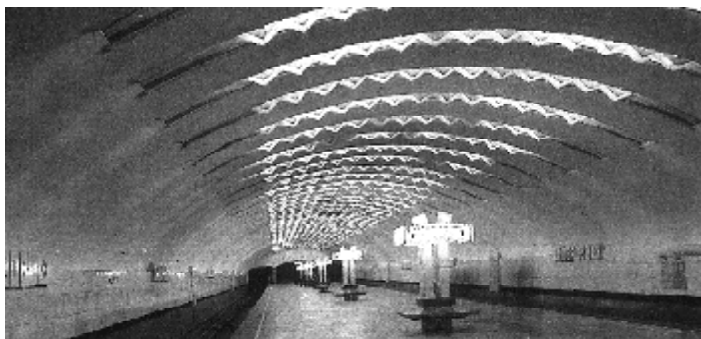
Рис. 4.13. Односклеписті станції метрополітену
