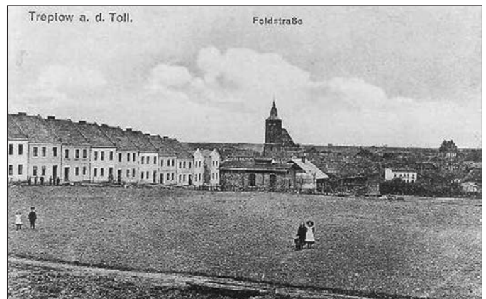
Unbebautes Land, 1928 Jahnstraße, 1934 - 35 Ernst-Moritz-Arndt-Straße erbaut
