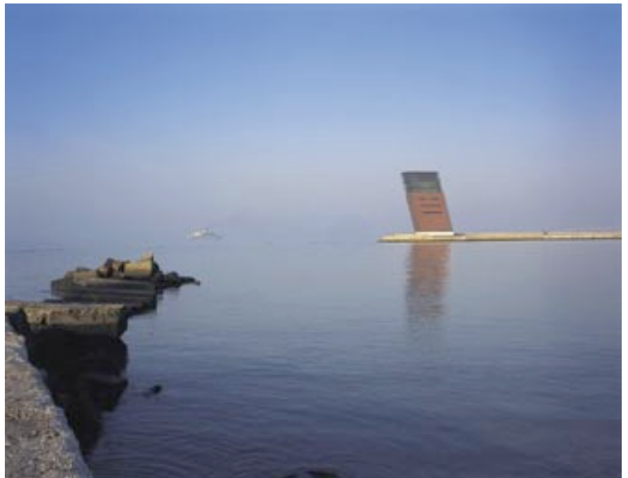
Centre de Coordination et Contrôle du Trafic Maritime du Port de Lisbonne, Portugal
