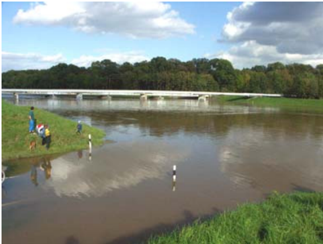
Hochwasser in der Elsterflutrinne an der Brückenstraße am 30.09.2007
