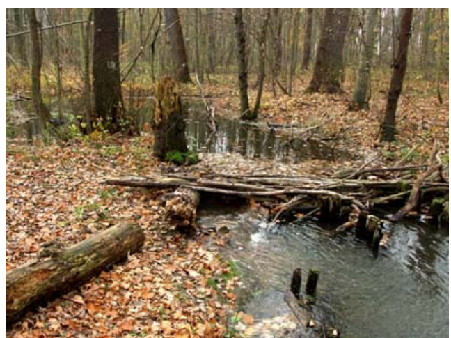
ehemalige Sohlschwelle - jetzt Knüppeldamm - kurz nach der Einmündung von P2
