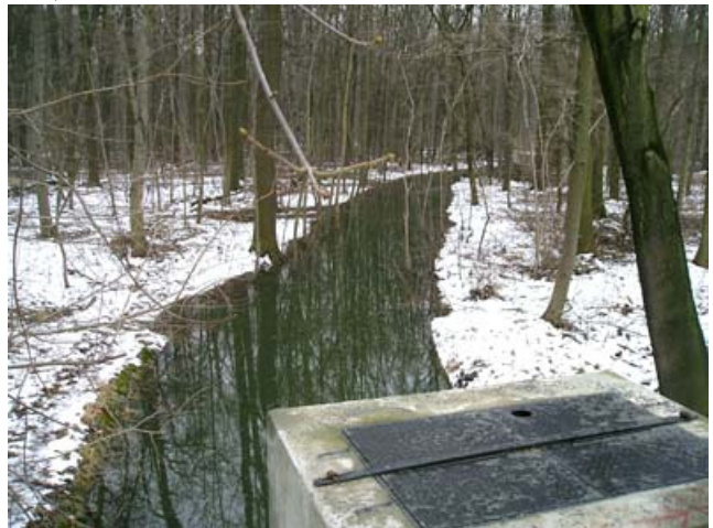
Abkürzung der Paußnitz zum Oberen Paußnitzziel - normalerweise ein tiefer Graben, bei dem sich im Herbst die ehemalige verrottete Sohlschwelle mit Laub verstopft hat; unten am 20.03.2006 - während der experimentellen Flutung der Probstei wird das Obere Paußnitzziel geschlossen, damit das Wasser über die Grabenkante ausläuft
