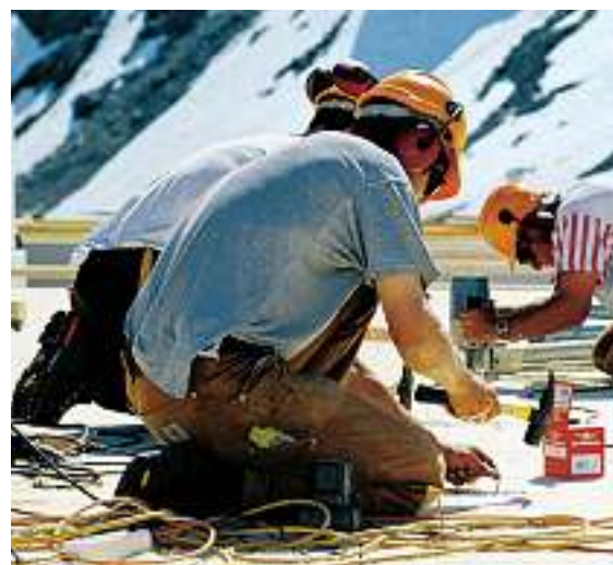
Bei einem Bauplatz in gebirger Umgebung ist das Wetter ein besonders wichtiger Faktor. Die Fertigelemente des Zwischenbodens werden befestigt.
