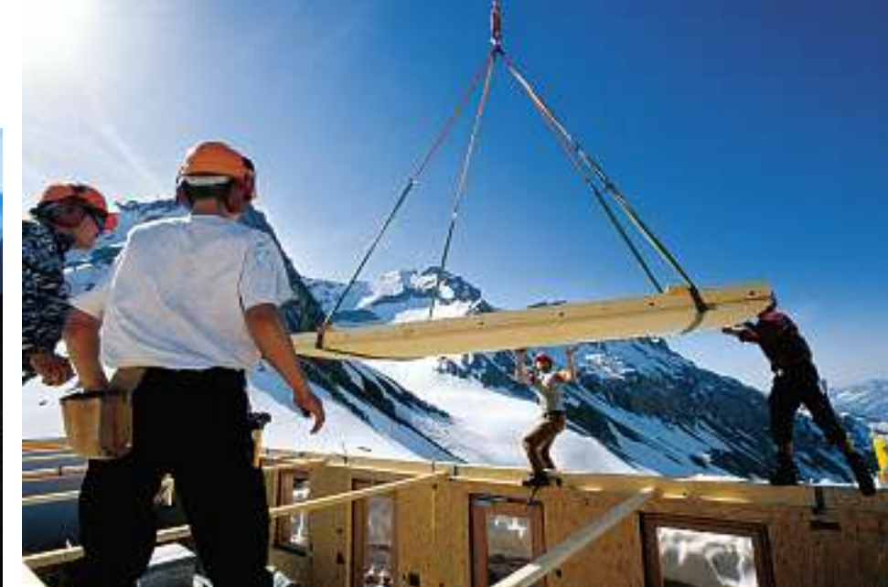
Das Erdgeschoss der Cristallina-Hütte steht. Nun werden die Elemente für den Zwischenboden angefliegen und platziert.
