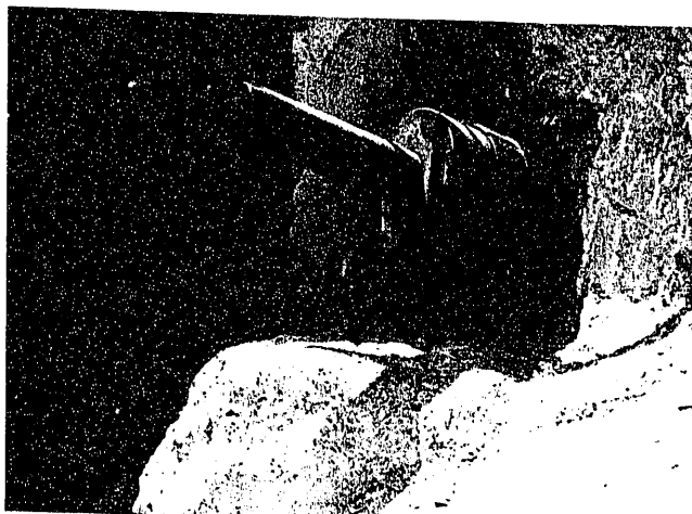
Anclaje de control después de quitar la cazoleta y limpiar el gel de protección.
