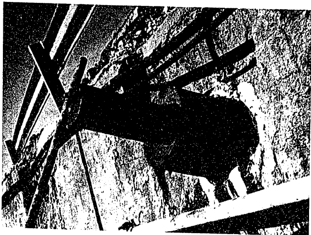
Anclaje de control con cazoleta de protección rellena de gel Cesacril.
