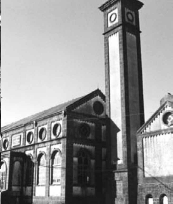
Usina de Aguas Corrientes, Canelones.
