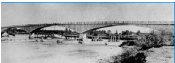
Il ponte di Chatel de Neuvre (1914-1923) ed il disarmo "automatico"
