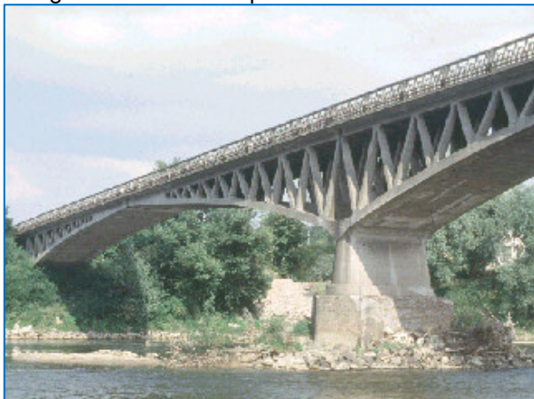
Il ponte di Chatel de Neuvre (1914-1923) ed il disarmo "automatico"
