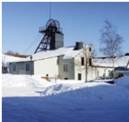
Der Betriebshof Clausthal der Harzwasserwerke GmbH am Kaiser-Wilhelm-Schacht
