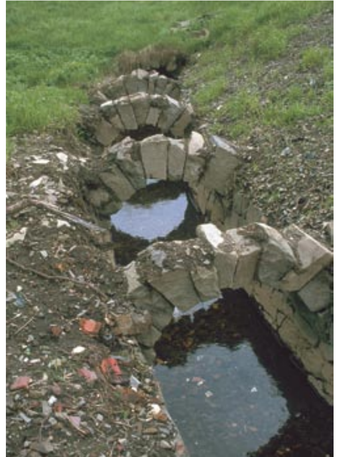
Bild 10: Steinbögen über einem Graben Die Lösung des Winterproblems an den Gräben war deren Abdeckung mit Fichtenreisig. Aus Gründen der Holzersparnis baute man dafür auch kleine Tragbögen
