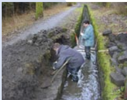
Dichtungsreparatur am Bremerhöher Graben
