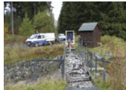
Sanierung des Fußgängersteiges über die Ausflut des Bärenbrucher Teiches
