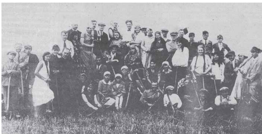
Kopiec w Płowcach – dokumentalne zdjęcie z początków jego budowy
