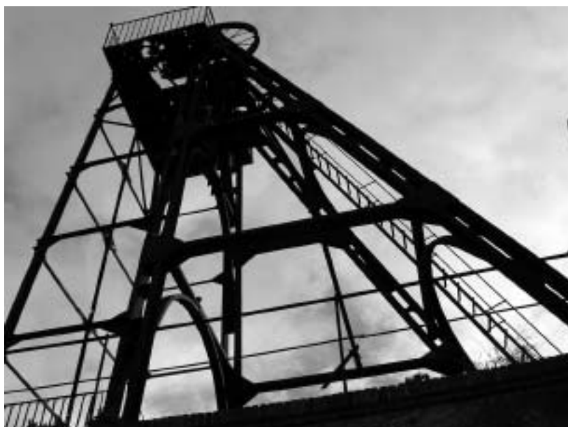
Castillete metálico de la mina La Mazarronera.
