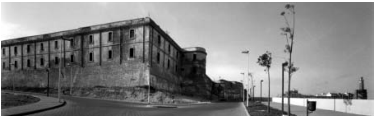
Vista sur - este.
