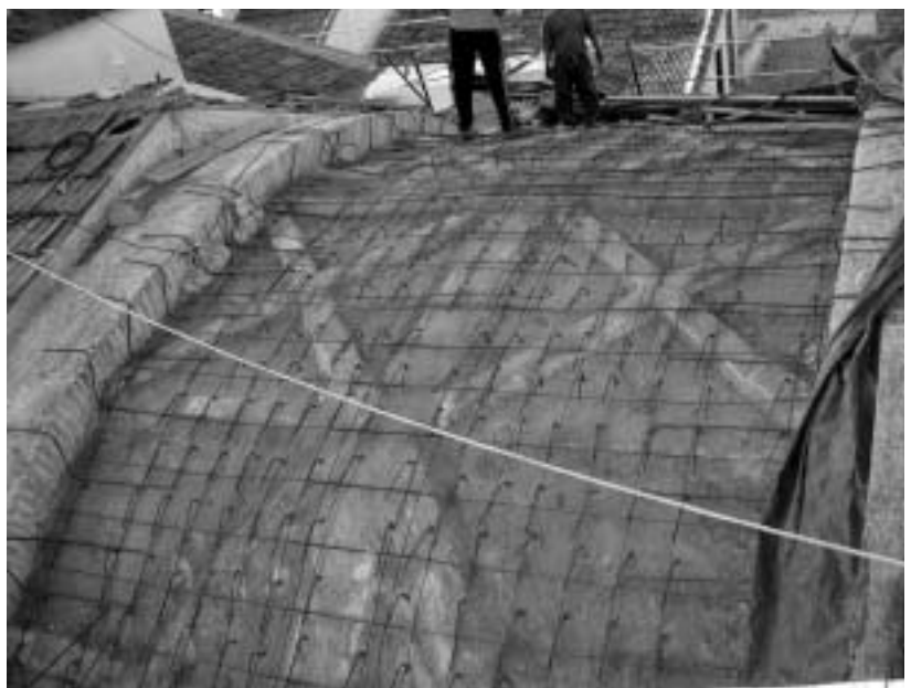
Detalle de los trabajos de consolidación de las bóvedas.
