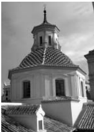
A la izquierda, fotografía 4 en la que aparece el tambor, la cubierta de la cúpula y la linterna con su capulín y aguja antes de la intervención y a la derecha, fotografía 5 con las mismas zonas ya intervenidas.
