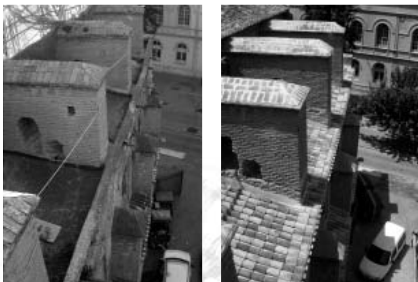
Fotografías 10 y 11 donde se aprecia el estado inicial y final de las cubiertas de la nave lateral Norte una vez desmontadas las terrazas y ejecutadas las cubiertas de teja.
