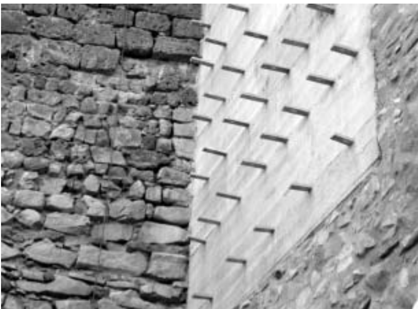
Detalle de la tapia una vez restaurada.
