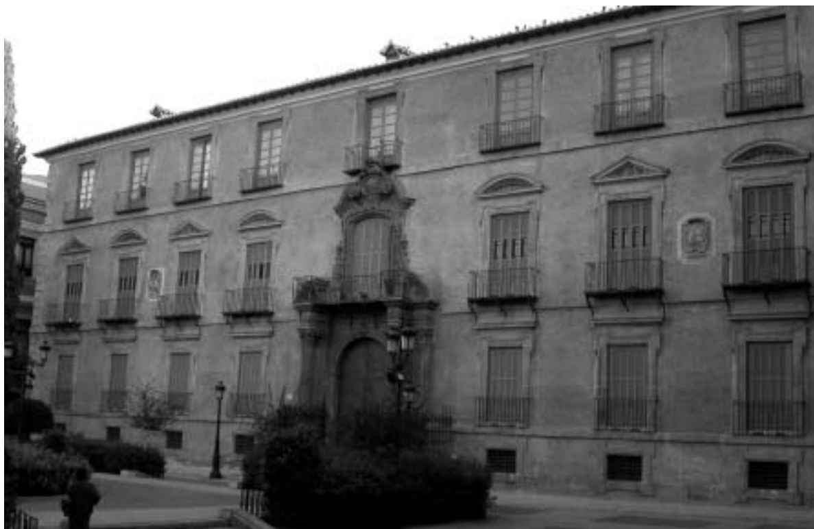
Fachada sur después de la intervención. Las carpinterías son nuevas manteniendo la tipología original. La portada pétrea y los recercados de balcones han sido restaurados con sillares nuevos y/o mortero pétreo, recuperando las molduraciones. Se eliminaron los árboles y el pequeño jardín que estaban pegados a la fachada y que aceleraban su deterioro.
