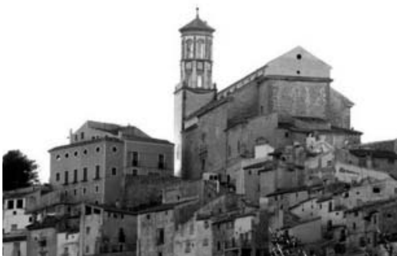
Vista de las fachadas lateral y posterior de la Iglesia.
