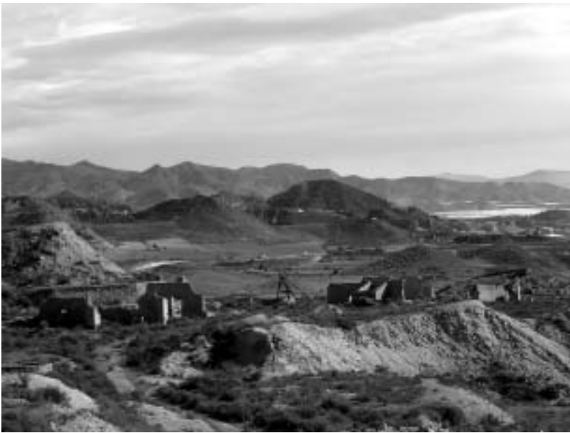
Vista general de algunas estructuras del conjunto Santa Isabel.
