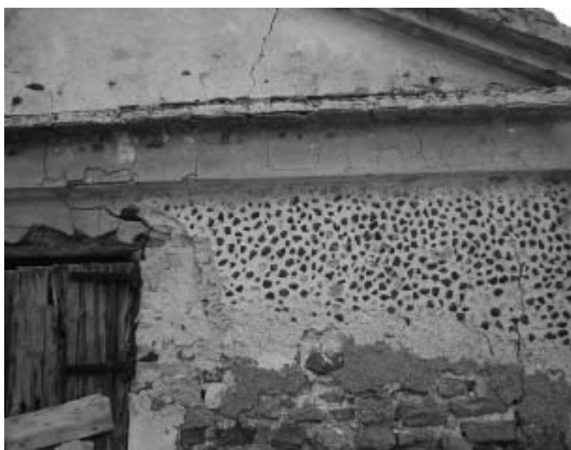
Alfól de La Ramona, Calasparra. Detalle del enfoscado de paramentos.
