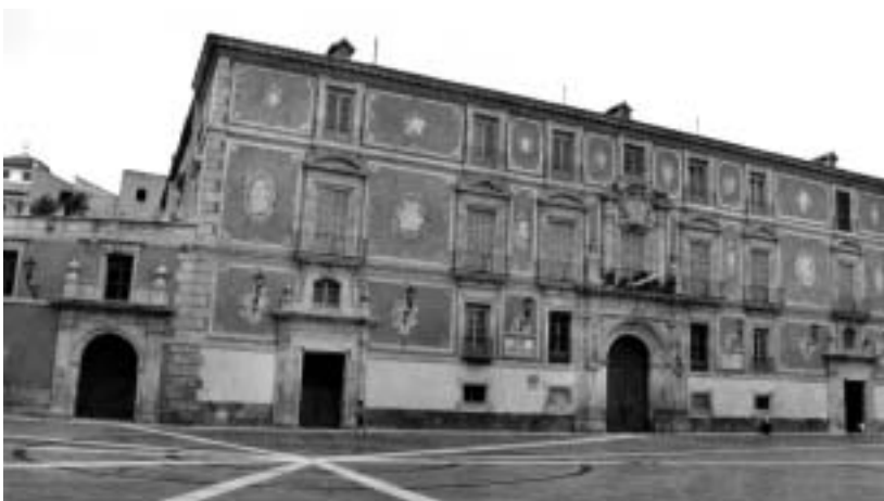
Fachada norte, principal, del Palacio una vez restaurada. Se ha recuperado la pintura mural (temple en seco) realizada por Paolo Pedemonte imitando tapices y rocallas con cornucopias en el centro a modo de medallones o espejos. Las portadas, recercados de balcones y zócalo de piedra han recuperado su aspecto original.
