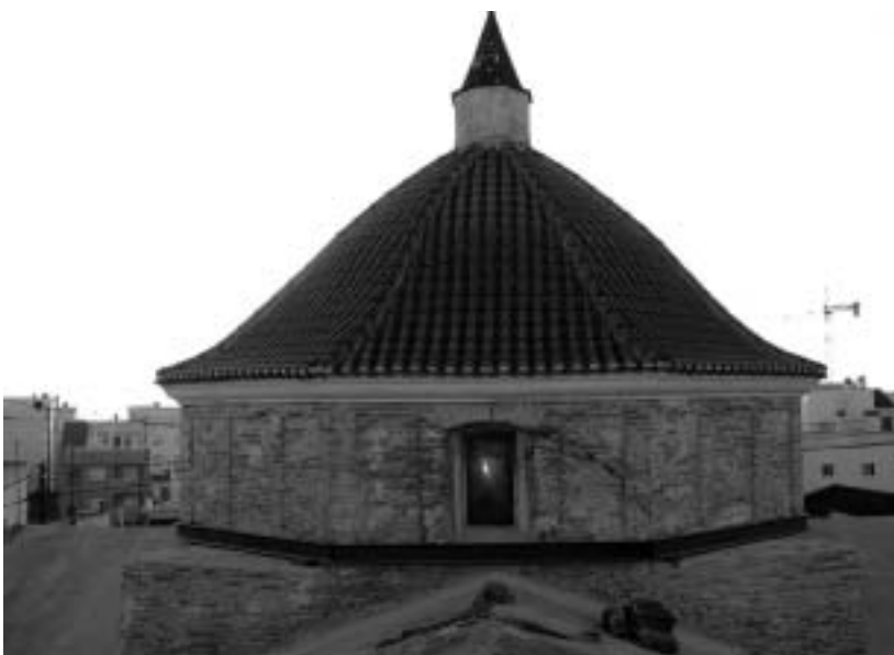
Vista general del zunchado del tambor de la cúpula central.
