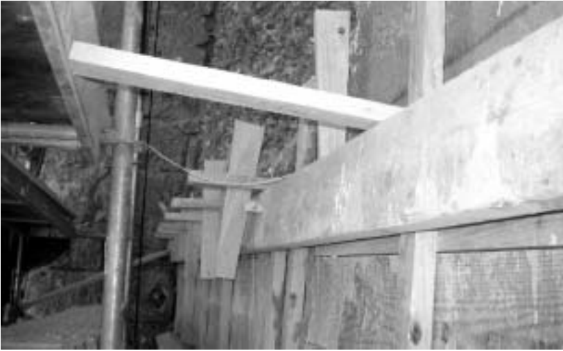
Detalle de la intervención: tapial de madera.
