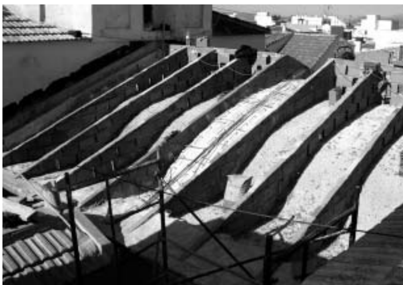
Formación de cubiertas con tabiques de ladrillo.
