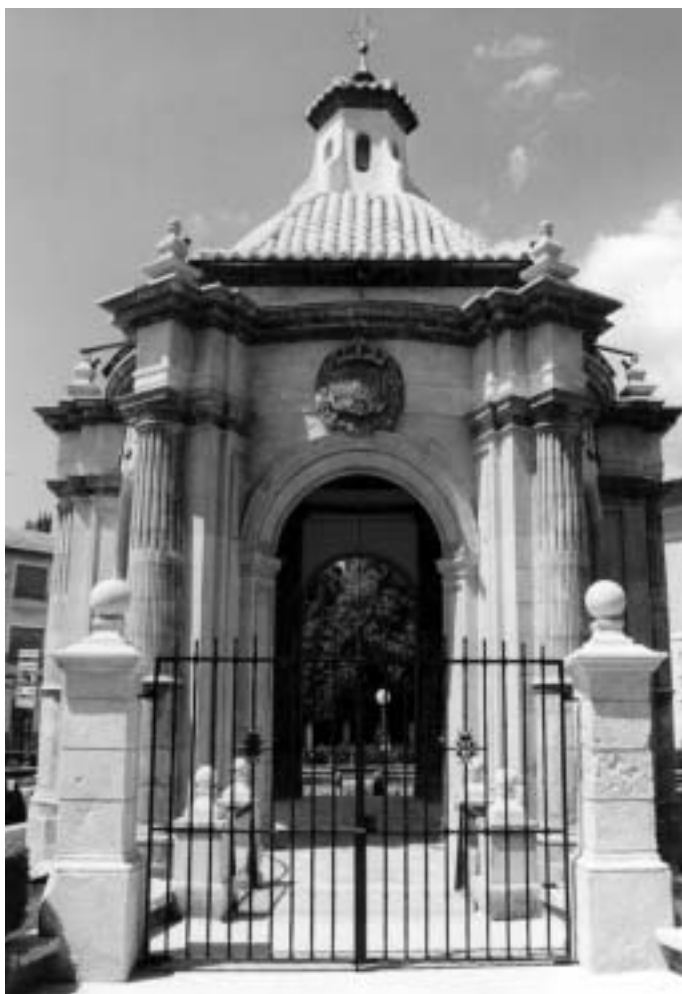
Vista general de la portada de acceso al Templete después de la restauración.
