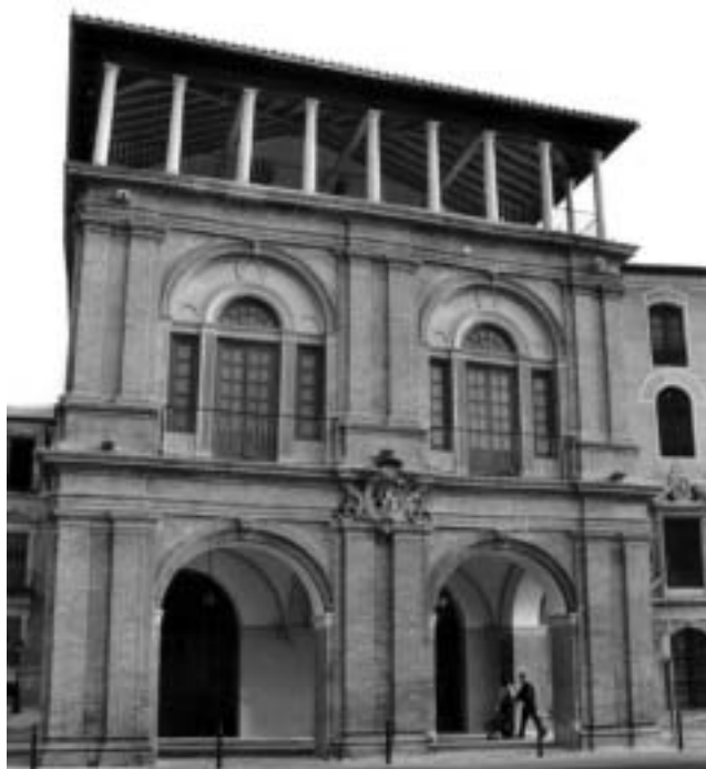
El Martillo restaurado. La estructura de madera que cubre la terraza y que estaba apoyada en perfiles metálicos por su pésimo estado de conservación, se cambió, eliminándose las vigas metálicas y colocando nueva vigería de madera. Las columnas han recuperado el revoco, las lagunas de la cornisa de piedra han sido resueltas con sillares moldurados y las fachadas de ladrillo han sido limpiadas y protegidas. El escudo se limpió con papetas de bicarbonato de amonio, se reintegró con mortero pétreo las lagunas de material y se policromó, resaltando su función ornamental.
