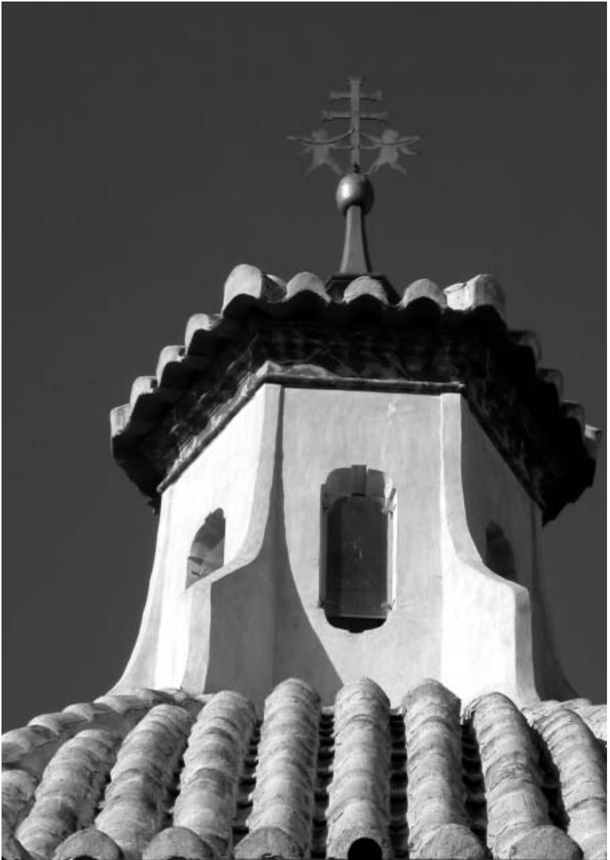
Vista del tambor después de la restauración.
