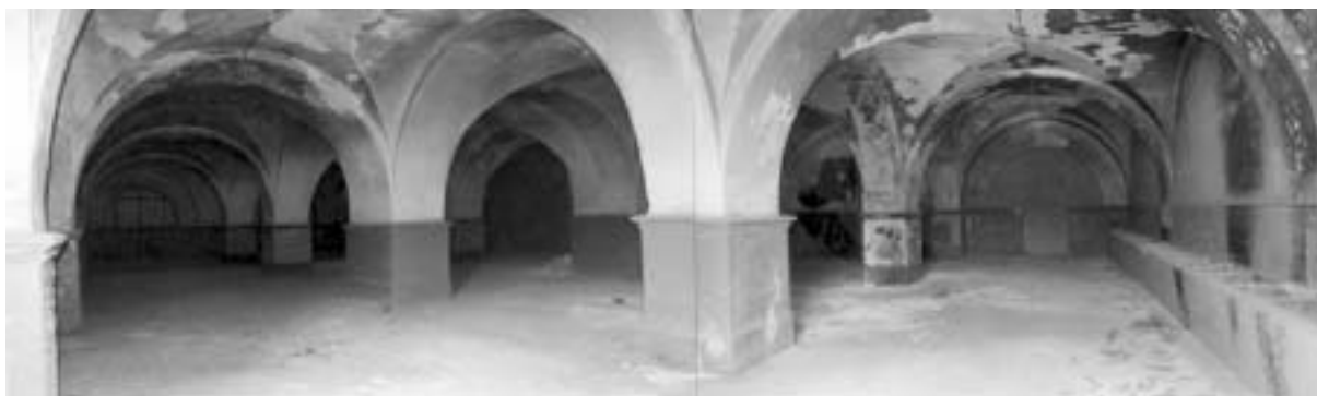
Interior planta baja. Ala norte. Caballerizas.
