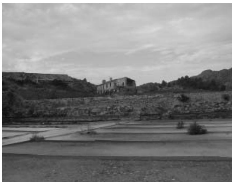
Panorámica con vivienda de operarios en las salinas de La Ramona, Calasparra.
