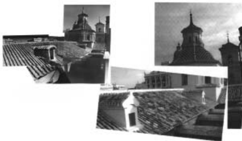
Fotografías 6 y 7 donde se aprecia el estado previo y final de las cubiertas de la nave central y los contrafuertes del lateral sur.
