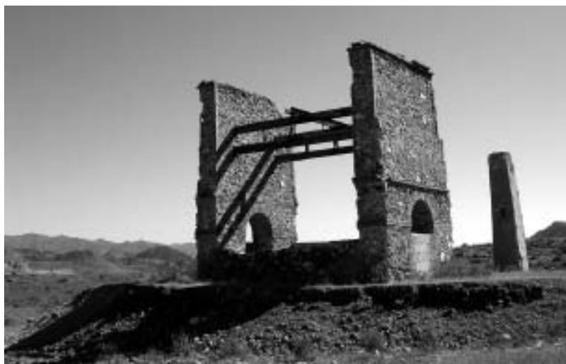
Castillete de mampostería del conjunto Purísima Concepción.
