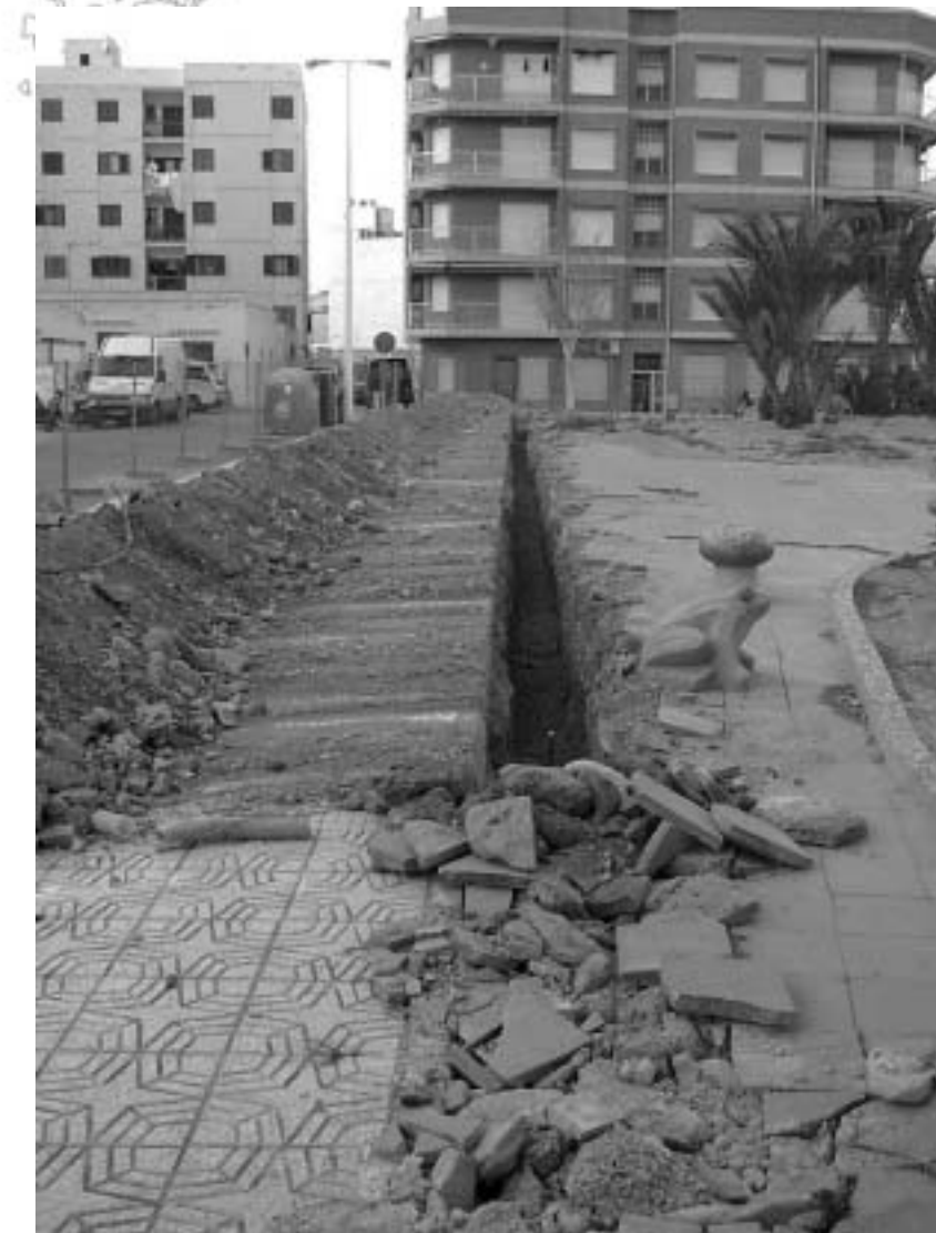
Vista parcial de la zanja en la plaza del Mar.
