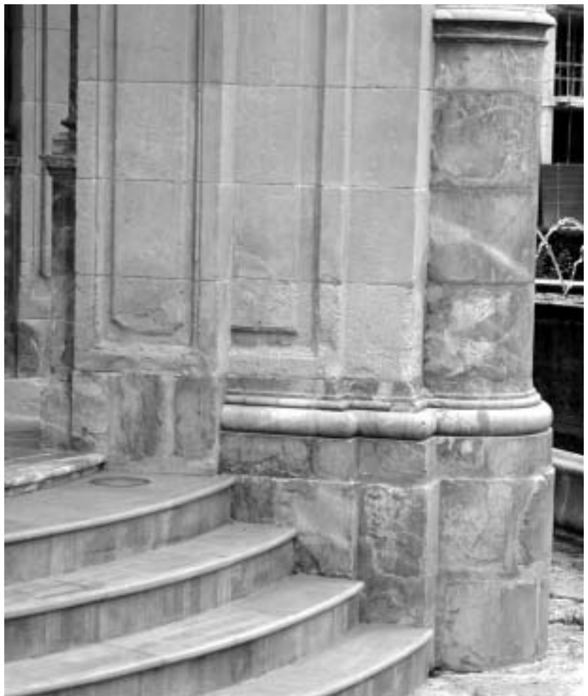
Detalle de una de las escalinatas y basas de mármol después de la restauración.
