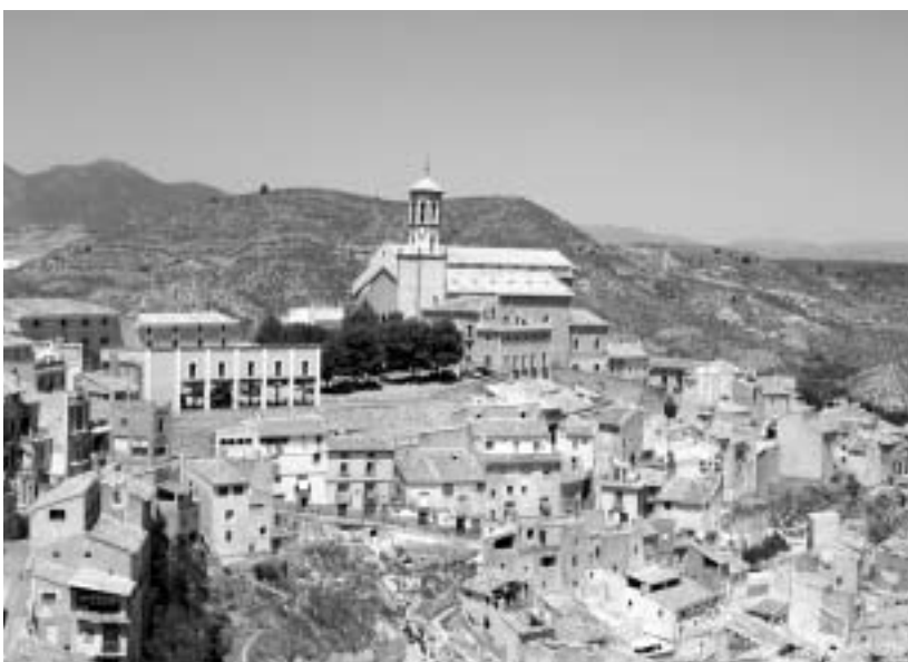
Vista general de la Iglesia de la Magdalena de Cehegín.
