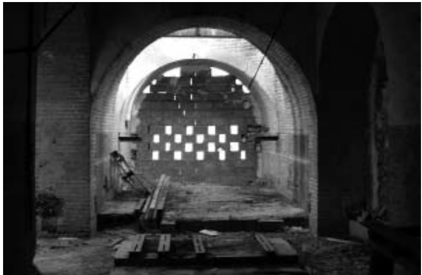
Área de entrada y salida al pozo San Carlos de la mina La Mazarronera. El acceso al pozo y una de las salidas al exterior de la mina están selladas con obra y bloques de hormigón.
