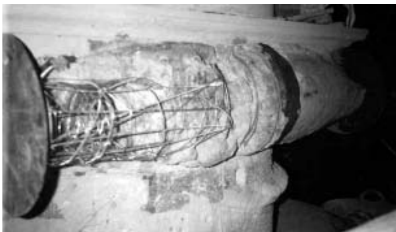
Detalle de la restauración de uno de los capiteles.
