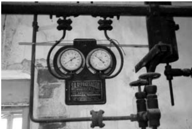
Fig 5: Control de Presión del Circuito de refrigeración de la cámara de enfriado.
