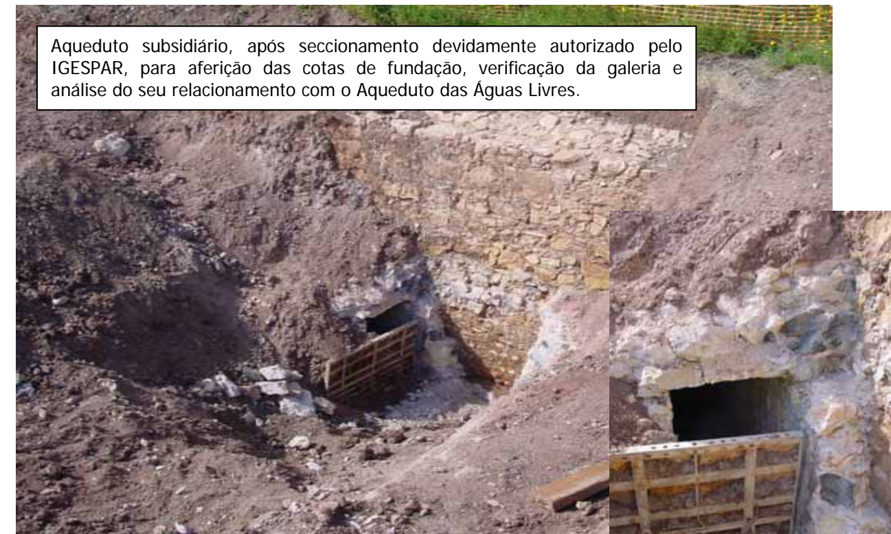
Pormenor das medidas de segurança adoptadas para evitar a intrusão de trabalhadores da obra, bem como de elementos alheio à mesma, no interior da estrutura, tendo-se deixado uma abertura para visualização da galeria.
