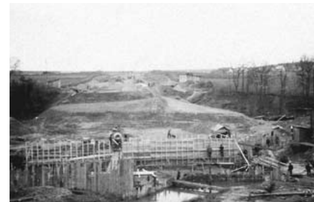
Stavba dálnice a dálničního mostu přes potok Botič u Průhonice (podzim 1939). Construction of the motorway and motorway bridge over the stream Botič by Průhonice (autumn 1939).
