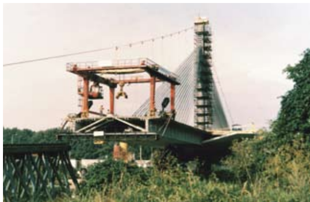
V roce 1987 dostává most přes Labe u Poděbrad na dálnici D11 zřetelné obrysy. In 1987 the bridge over the Labe River by Poděbrady on the D11 motorway gets its visible shape.
