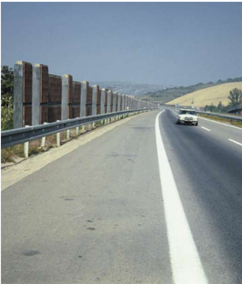
Protihluková stěna u Hustopečí na dálnici D2. Sound barrier by Hustopeče on the D2 motorway.
