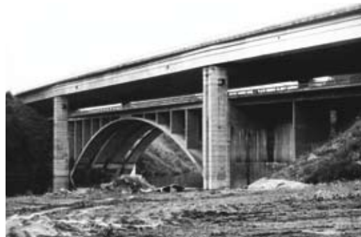
Nástavba mostu po dokončení. Bridge addition after completion.
