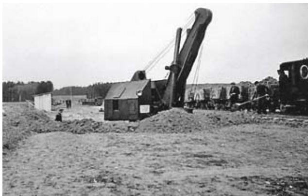
Zemní práce u obce Bernartice (podzim 1939). Typické je využití stavební drážky a velkokapacitního rypadla. Ground work by the village of Bernartice (autumn 1939). The use of construction trench digger and a large-capacity excavator is typical.
