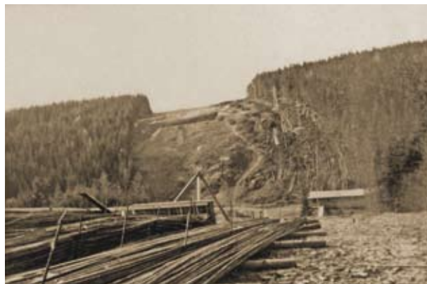
Staveniště dálničního mostu přes údolí Sedlického potoka u Borovska (podzim 1939). Z důvodu mimořádné dopravní odlehlosti staveniště zakoupilo GŘSD několik hektarů okolního lesa jako zdroj dřeva pro skruž mostu. The construction site of the motorway bridge across the Sedlický stream valley by Borovsko (autumn 1939). Due to the construction site's extraordinary remoteness from transport routes, the General Directorate of Motorway Construction purchased several hectares of the surrounding forest as a source of wood for the bridge's formwork.
