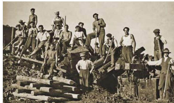
Dělníci na stavbě průchozí dálnice u obce Borotín (léto 1941). Workers building the transit motorway by the village of Borotín (summer 1941).
