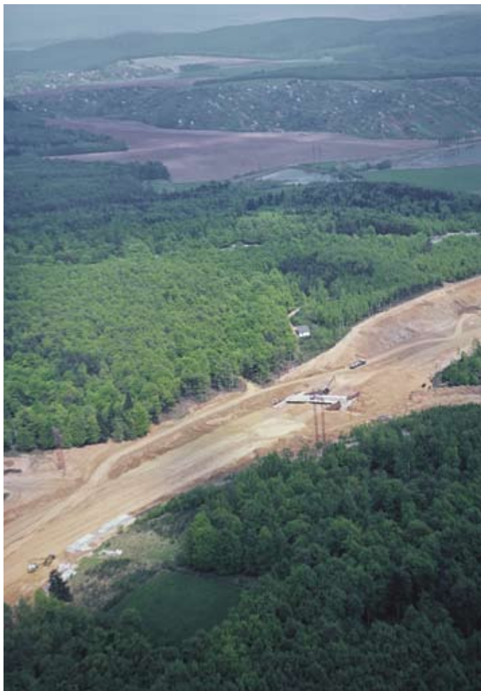
Také na výpadu z Brna je v roce 1970 patrný postup. Dokončuje se hluboký zářez u Kývalky. In 1970 progress is also visible in the thrust from Brno. A deep cut by Kývalka is finished.
