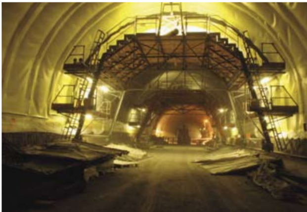
Dálnice D47, výstavba tunelu Klimkovice. D47 Motorway, construction of the Klimkovice tunnel.
