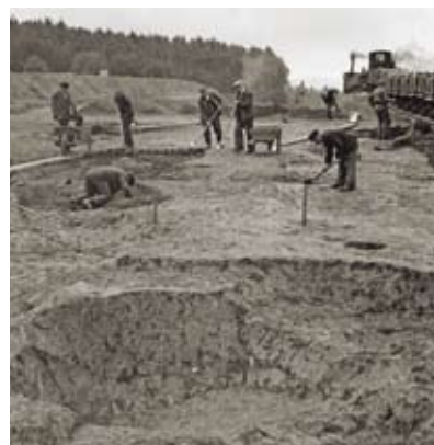
Zemní práce na průchozí dálnici u obce Chornice s typickým využitím pracovního vlaku (říjen 1939). Groundwork on the transit motorway by the village of Chornice with the typical use of a work train (October 1939).
