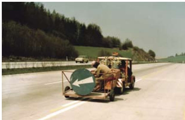
Přechod ze žlutého na bílé vodorovné dopravní značení. Když se ukázalo, že naše i evropské normy připouštějí bílé značení i pro dálnice, bylo od devizového nákupu žluté barvy upuštěno. Transition from yellow to white horizontal traffic signs. When it turned out that both our standards and European standards allow white road markings for motorways as well, the foreign purchase of yellow paint was abandoned.
