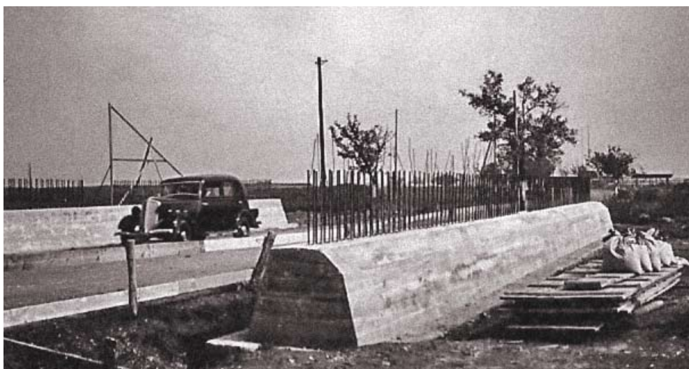
Základy dálničního mostu přes budovanou silnici Plzeň–Moravská Ostrava u obce Loket (léto 1939). Foundations for the motorway bridge across the Pilsen–Moravská Ostrava road built by Locket village (summer 1939).
