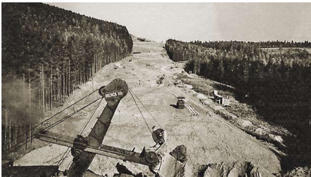
Zemní práce v klesání do údolí řeky Blanice v roce 1941. Groundwork in the descent to the Blanice River valley in 1941.
