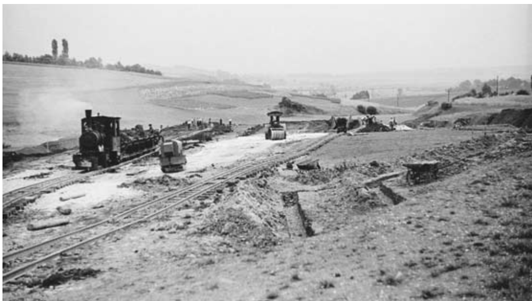
Stavební práce na sudetské dálnici u Chebu v červnu 1939. Tato velkoryse pojatá stavba (32 m šířky v koruně) byla na rozdíl od průchozí dálnice a naší dálnice Praha–Brno–slovenská hranice z nezjistitelných příčin brzy utlumena a nijak výrazně nepokročila. Construction work on the Sudeten motorway by Cheb in June 1939. This generously interpreted civil engineering project (32 m wide at its head) was, in contrast with the transit motorway and our Prague–Brno–Slovak border motorway toned down and did not proceed in any significant way.
