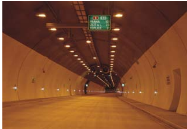
Dálnice D8, tunel Panenská. D8 Motorway, Panenská tunnel.
