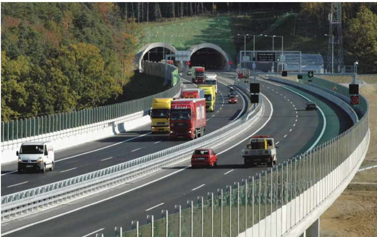
Dálnice D5, most přes řeku Úhlavu a tunel pod vrchem Valík. The D5 Motorway, the bridge over the Úhlava River and the tunnel under the Valík peak.
