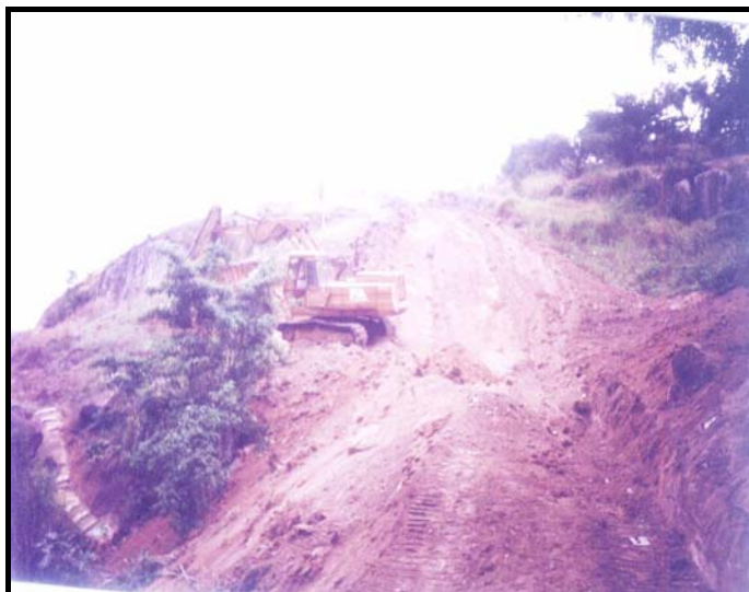
Foto 01 – Decapagem do terreno
