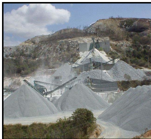
Foto 06 – Pátio de britagem
