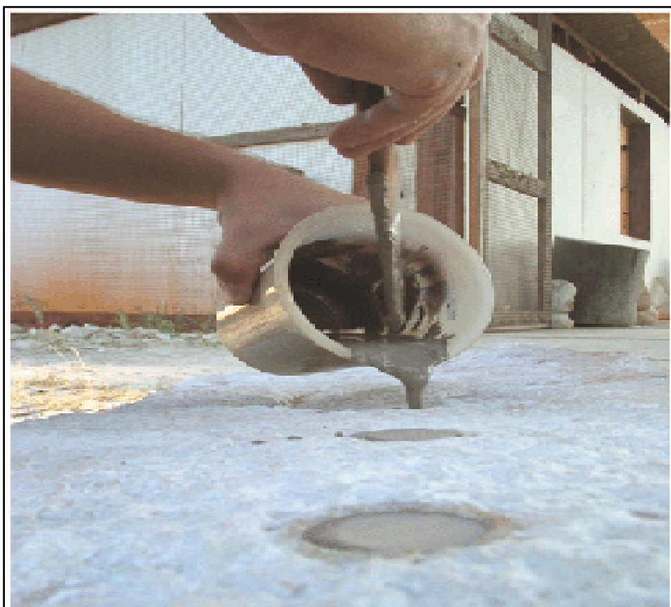
Foto 22 - Operação de carregamento dos furos com a argamassa expansiva.
