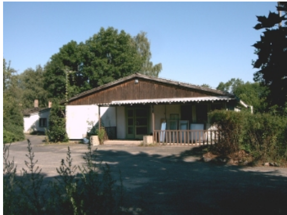
Abbildung 11: Funktionsbaracke des ehemaligen Aufnahmeheims Blankenfelder Chaussee 59, 2007
