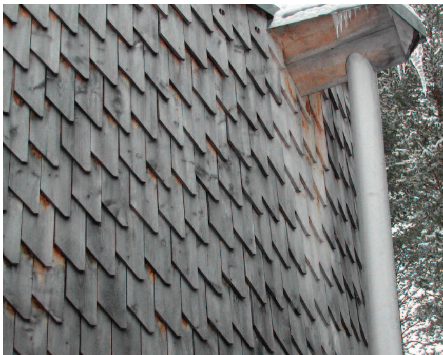
Byggdetaljer er veldig viktig for å unngå fargeskjolding på ubehandlet virke.
