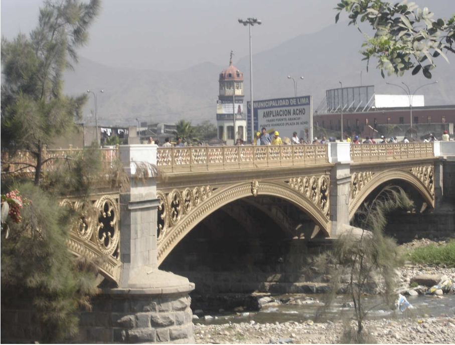
Restaurado puente balta este comunicaba con la alameda de Acho
