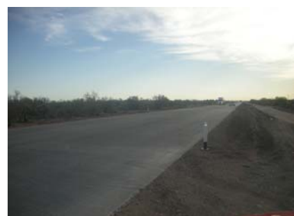
Tramo de la carretera Altar – Pitiquito, modernizada en el periodo enero – junio de 2008.
