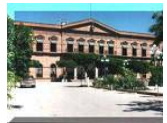
Primera sede del Gobierno Estatal y del Congreso Constituyente del Estado de Occidente. El Fuerte, Sinaloa.
