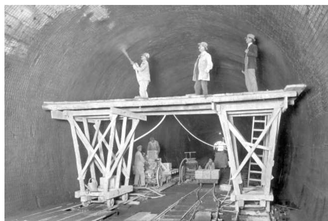
6 Spritzbetonarbeit im Ulmbergtunnel in Zürich (1927): Umbau eines Bahntunnels in einen Straßentunnel (Foto: D. Prader)
