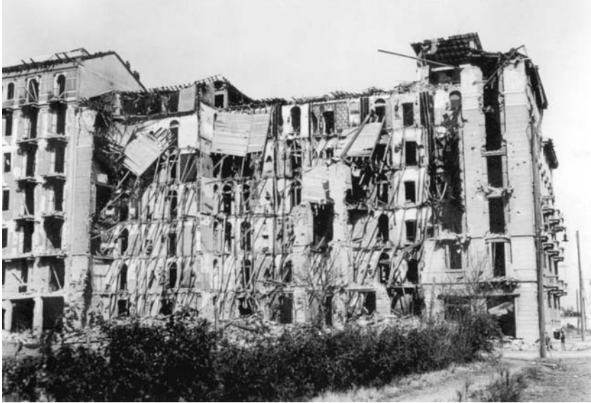
Via Lomellina, angolo via Sismondi, dopo i bombardamenti dell'agosto 1943
