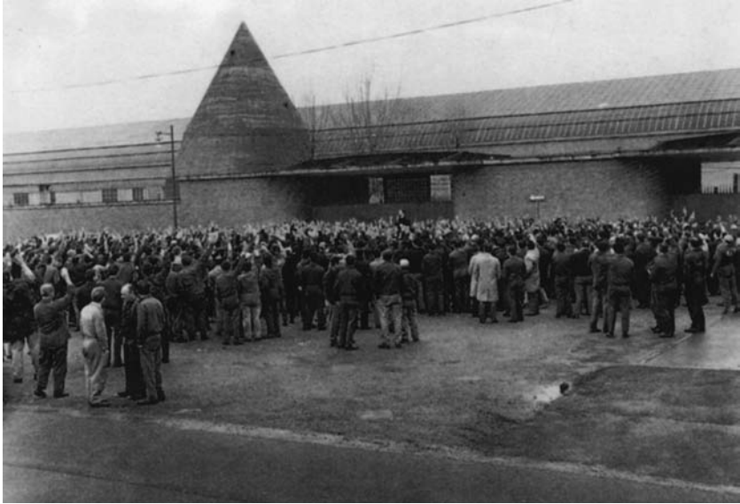
Rifugio antiaereo in cemento armato a forma di ogiva ancora visibile in via Pitteri, dove un tempo era situato uno dei "Complessi di guerra" dell' Innocenti
