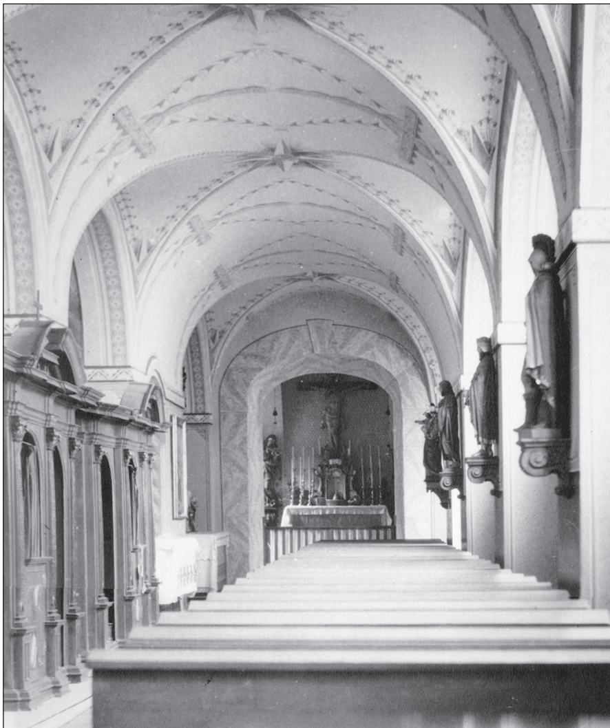
Chodba ambitu před likvidací hájeckého kláštera v roce 1950.
