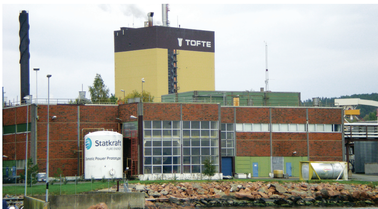
Bak de store vinduene bygger Statkraft verdens første saltkraftprototyp.
