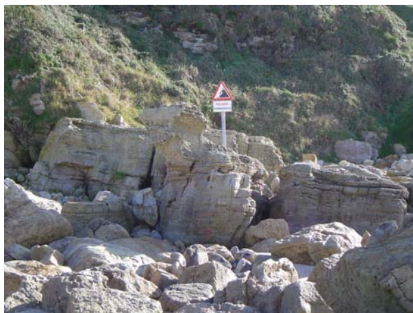
Imagen 12. Riesgo por caída de bloques.
