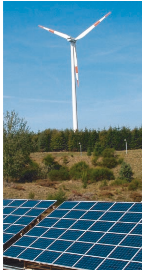
Die garantierte Vergütung für regenerativen Strom bringt Investitionssicherheit.
