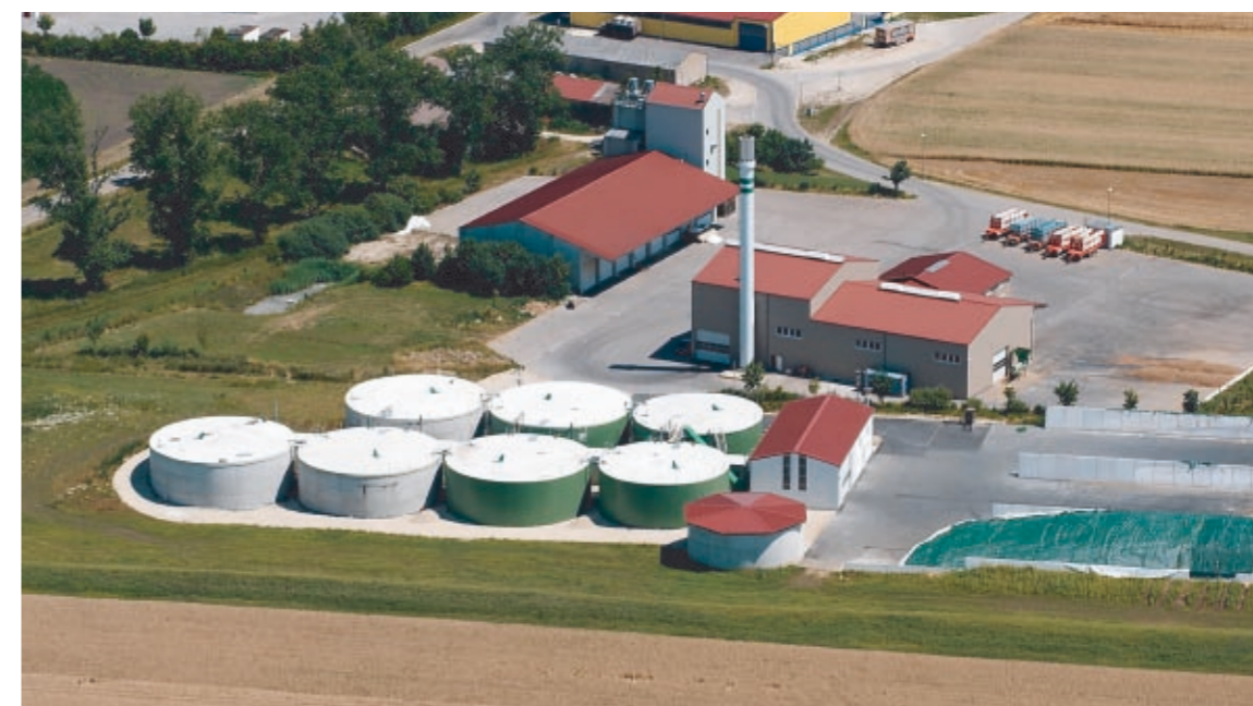
Strom und Wärme fürs Dorf: Eine Biogasanlage in Wechingen (Bayern).
