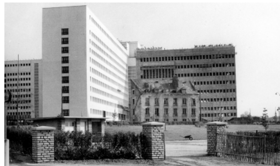
Construction du nouvel hôpital 4 mai 1960 (24 Fi 4064)
