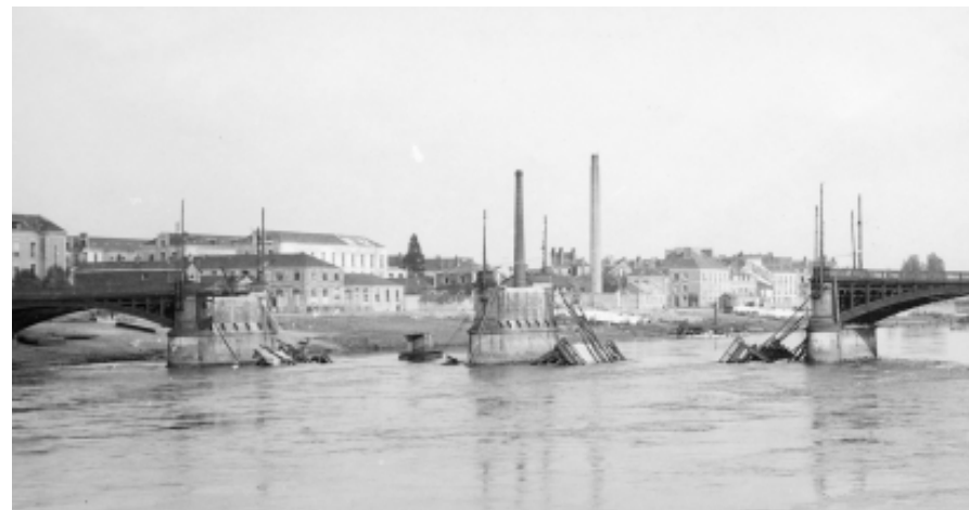
Pont Haudaudine : Construit en 1878, deux de ces arches sont détruites par les Allemands. Le pont est remis à la circulation le 17 août 1945 (22Fi339).
