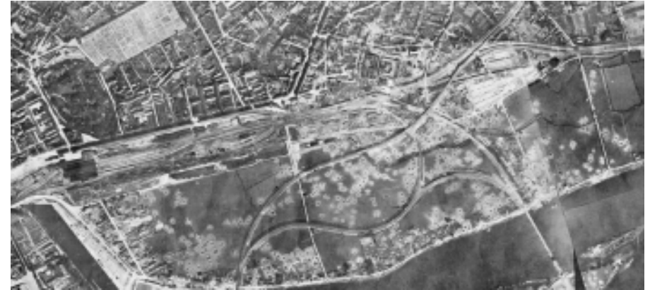
Cratères laissés par les bombes quai de Malakoff et prairie de Mauves, 1944 (photo aérienne Malakoff)
