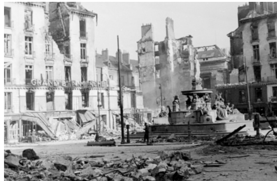
La Place Royale après le bombardement du 16 septembre 1943 (22 Fi 115)
