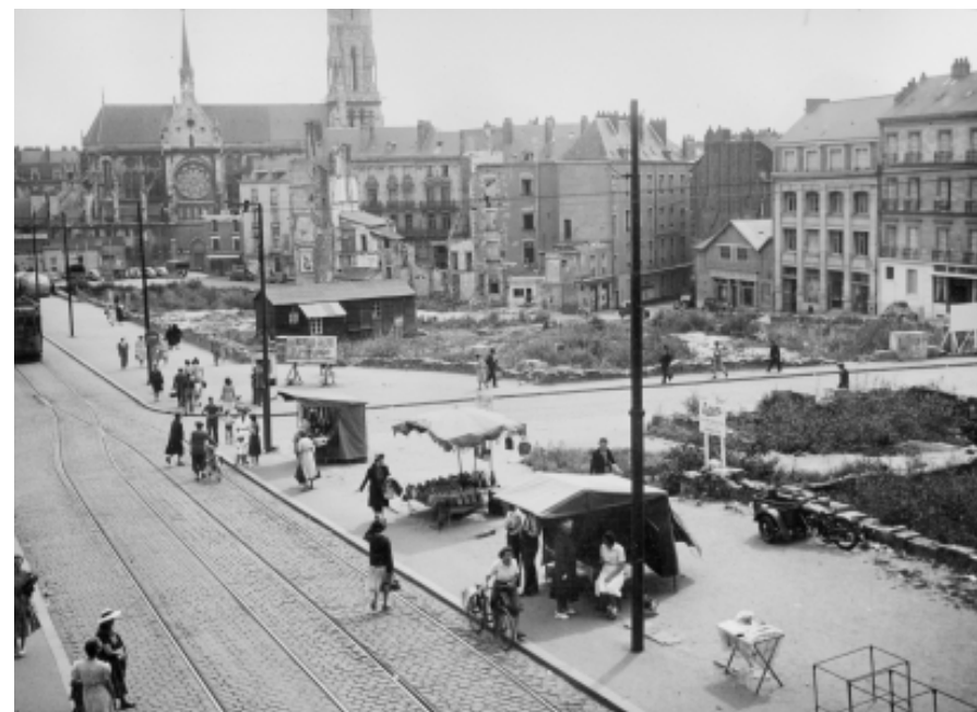
La rue du Calvaire déblayée avant les travaux, 10 août 1950 (Album 301 cliché 10)
