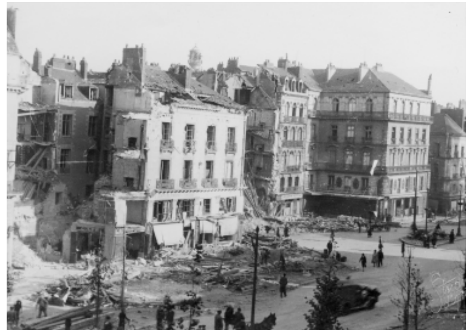
Immeubles détruits place de l'Ecluse, septembre 1943 (22Fi50)
