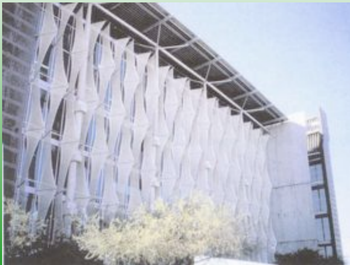
Facciata a nord
