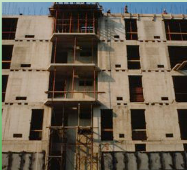
Particolare della facciata in costruzione
