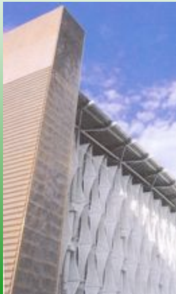
Facciata a nord con particolare della schermatura
