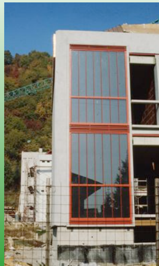
Particolare dell'installazione del sistema
