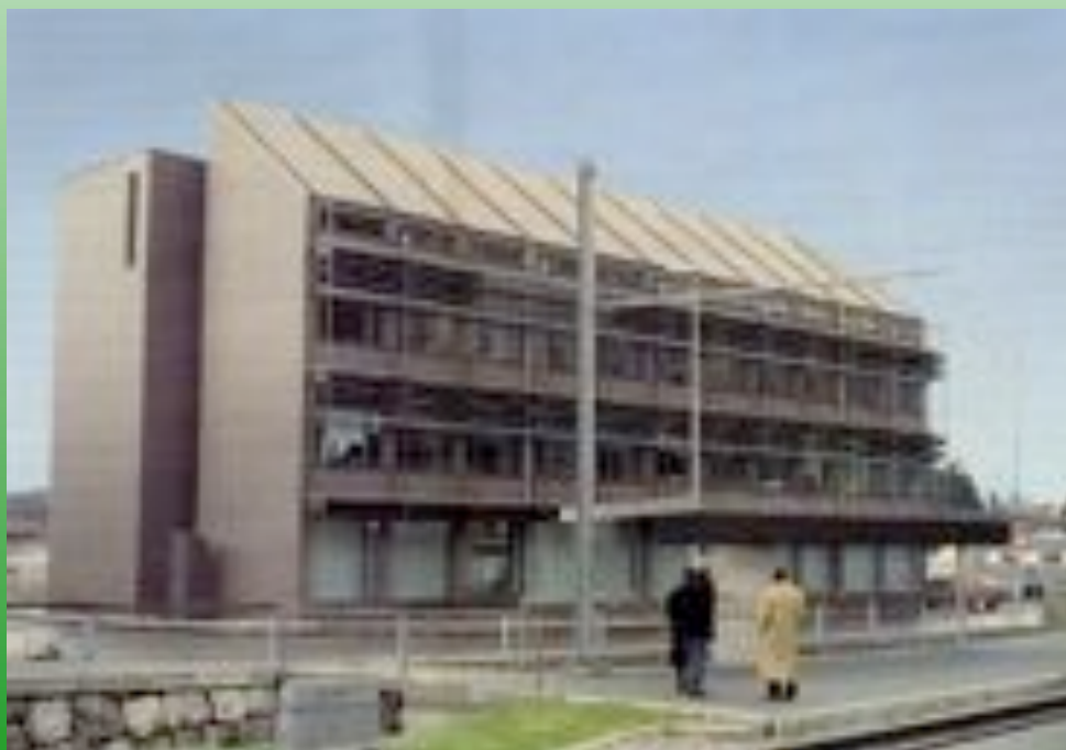
Facciata principale e particolare del sistema di schermatura
