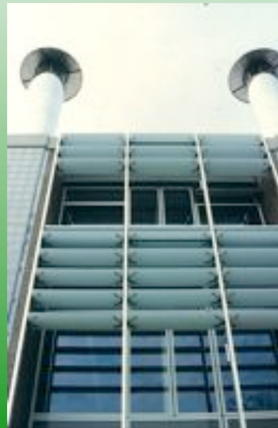
Particolare delle lamelle
