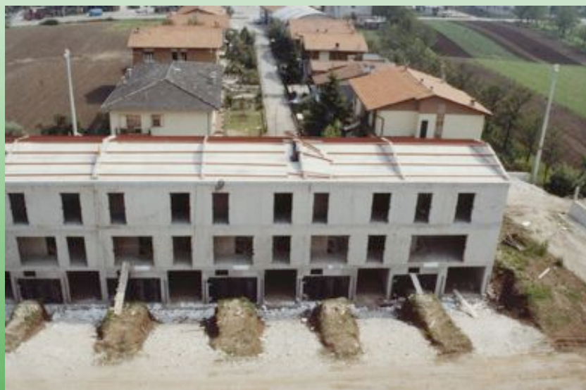
Edificio in costruzione
