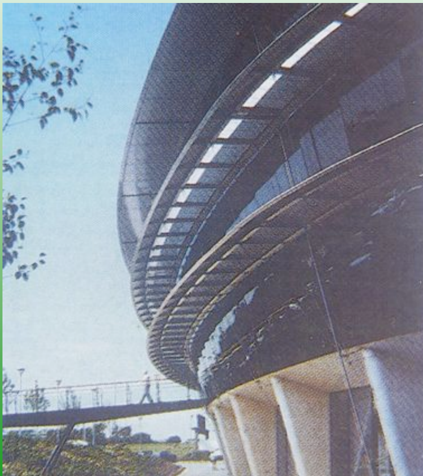
Vista della facciata
