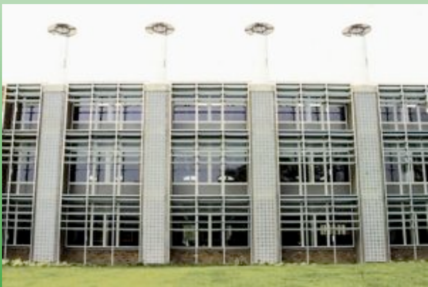
Vista della facciata
