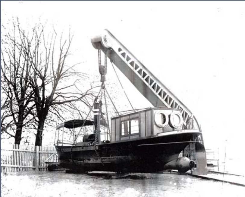
Versuche mit Wasserstrahltrieben (Turbinenpropeller mit Rückstrahler) bei der KETTE – Deutsche Elbschiffahrts-Gesellschaft in Übigau (1890-1895)
