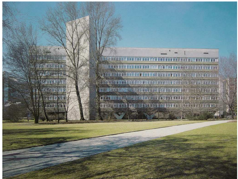
Haus Niemeyer, Ostseite
