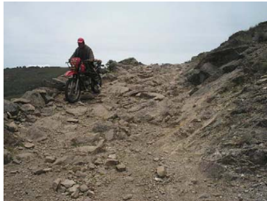
Tramo La Unión – Huaynas (Dist. Huaso)
