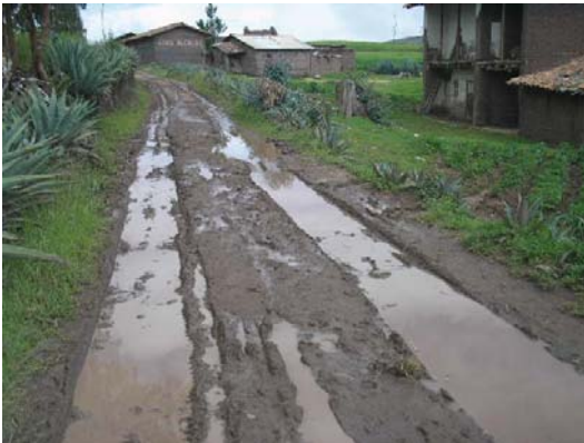
Tramo Oromalqui Villamaría (Dist. Carabamba)
