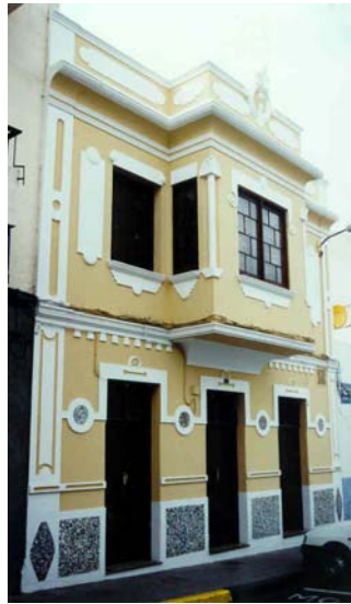
Figs. 17 y 18. Arriba, casa de Antonio Armas con fachada de bloques almohadillados y friso, con un estilo de clara influencia de la decoración traída desde Cuba por Simeón Rodríguez. Abajo, casa de Francisco Araújo, década de 1940, en La Plaza, una de las últimas obras levantadas en La Aldea con preocupación de estilo.
