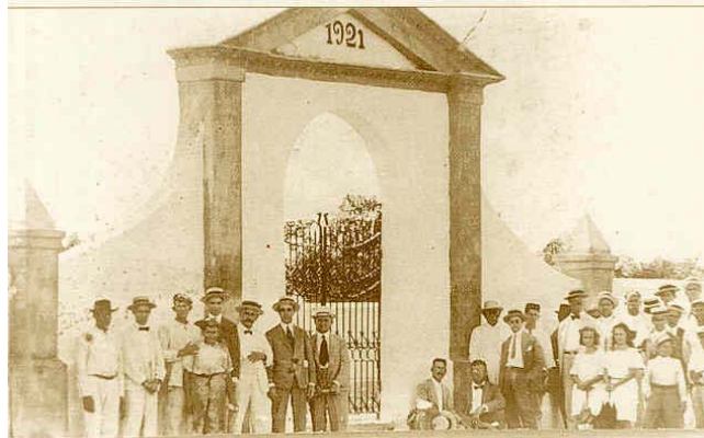
Figs. 32 y 33. Día de la inauguración del cementerio de Isabela de Sagua. Arriba, dentro del mismo en el momento de la entrega de la obra por el constructor Simeón Rodríguez (sentado en el centro) a las autoridades y vecinos. Abajo, fuera del mismo en la fachada principal. Año 1921. Obra hoy desaparecida. Fotografías de los archivos personales de Primitiva (La Aldea) y José Rodríguez (Santa Clara) respectivamente.
