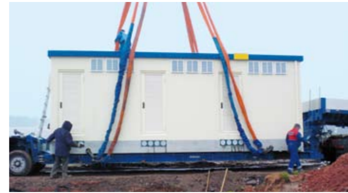
16. Oktober 2008: Aufstellung der Wechselrichterstationen.
