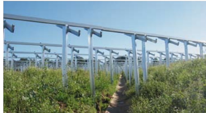
11. August 2008: Beginn der Bauarbeiten. Einrammen der Tragpfosten, Aufbau der Traggestelle und Modulmontage.
