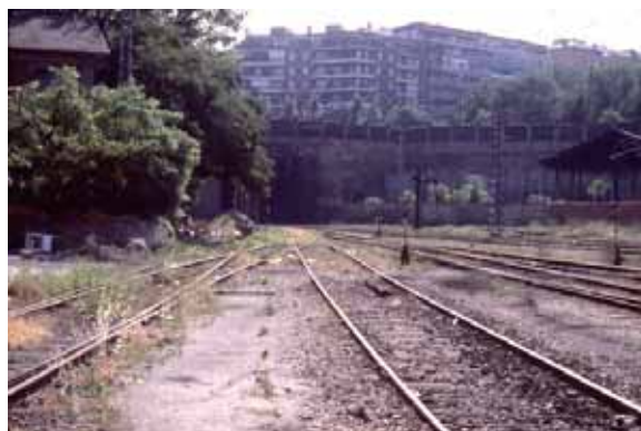
Figura 31. Pasillo Verde Ferroviario. Las obras para enterrar la Vía Férrea sacaron a la luz numerosos y relevantes yacimientos de fósiles del terciario madrileño
