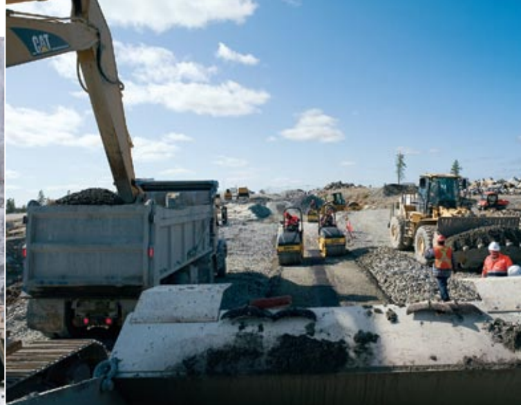
Construction du barrage de la Nemiscau-1, à la Baie-James. Ce barrage a été étanchéifié au moyen d'un noyau de béton asphaltique – une première nord-américaine.
