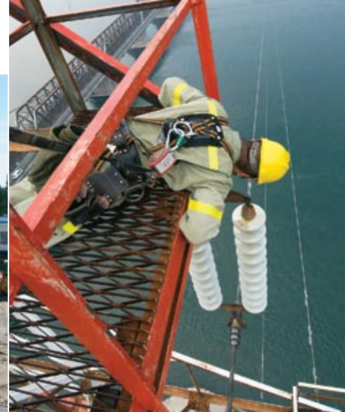
Inspection d'un support de traversée fluviale, entre Montréal et Saint-Lambert.
