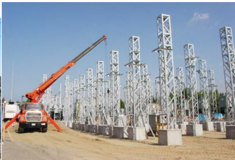
Construction du poste de Saint-Lin, dans les Laurentides.
