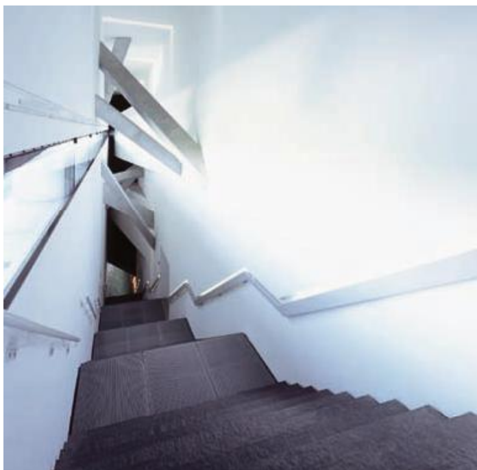
Oben: Baumdicke Betonstreben durchdringen die Haupttreppe des Libeskind-Baus
