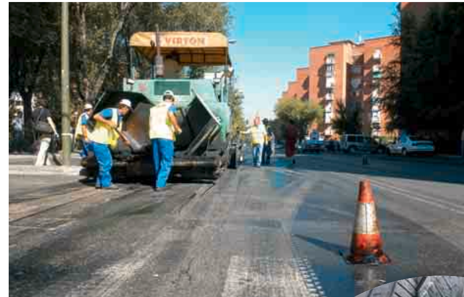
► El asfalto-caucho ha empezado a utilizarse en vías urbanas.
