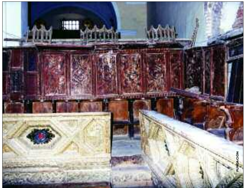
Aspecto general del coro antes del desmontaje.
