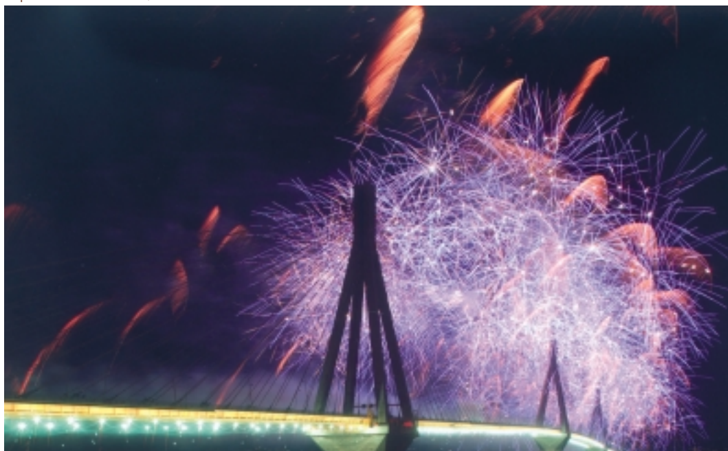
Le pont de Rion-Antirion, Grèce.
