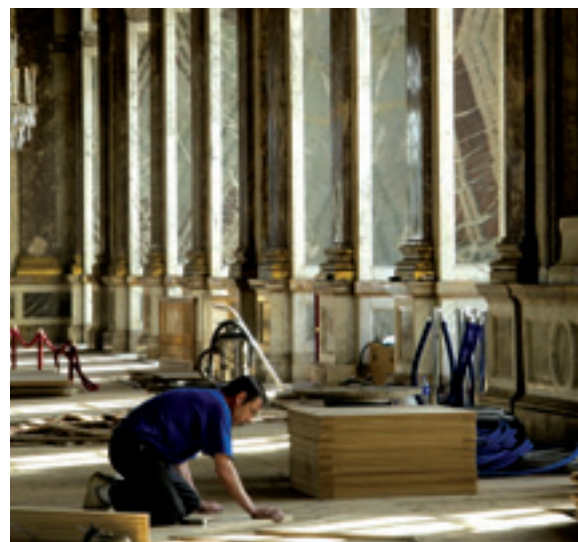
Les 700 m 2 de parquet ont été refaits en trois mois.
