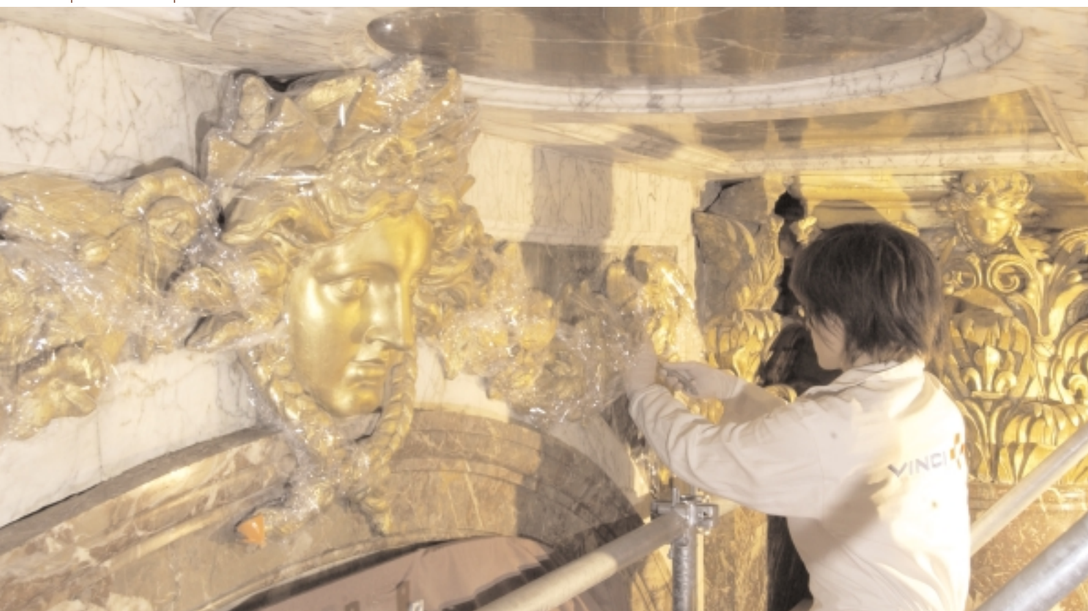
Mise en place d'un film de protection sur les dorures.
