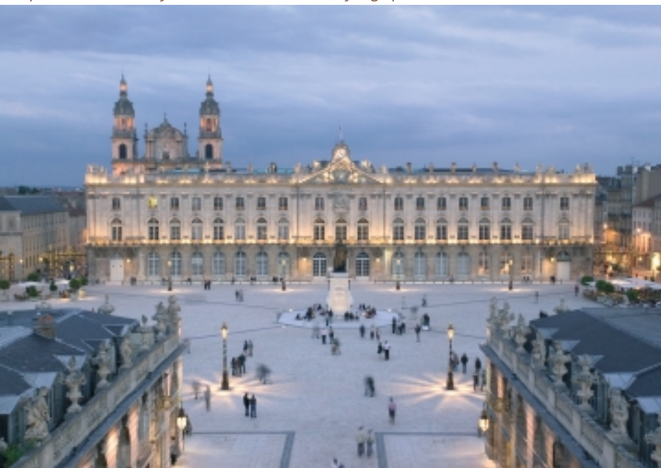
La place Stanislas à Nancy, une restauration réalisée en synergie par VINCI.
