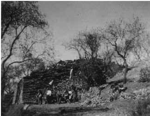
Fig. 3.- La cuadrilla apilando el corcho junto a Mosquera.
