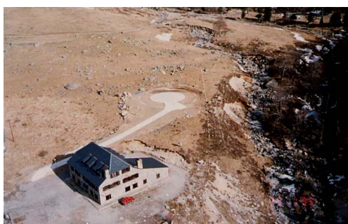
Boca sud Túnel de Viella
