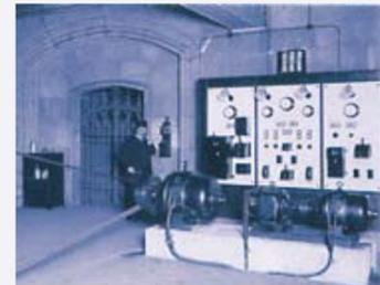
Erste Elektrifizierung der Glocken im Kölner Dom. Die Maschine treibt präzise drei Glocken gleichzeitig an.
