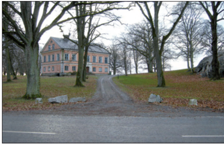
Figur 9. Infarten till förvaltarbostaden berördes inte av kantskärningen. På varje sida av vägen finns fungerande brunnar. Fotograferat från nordost av Maud Emanuelsson.
