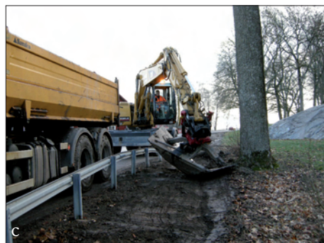
Figur 3 a-d. Arbetet inleddes onsdagen den 26 november. Dagarna före hade det snöat ymnigt (a), vilket till viss del försämrade arbetet. När snön smälte under dag två utfördes arbetet delvis i skymningsljus (b). Inga rötter fick skadas (c). Maskinisten måste därför ta stor hänsyn till parkträden. Alla massor lades på lastbilsflaket (d) och tippades på plats som anvisats av fastighetsägaren. Notera även den specialbyggda släntskopian (d). Fotograferat av Maud Emanuelsson.
