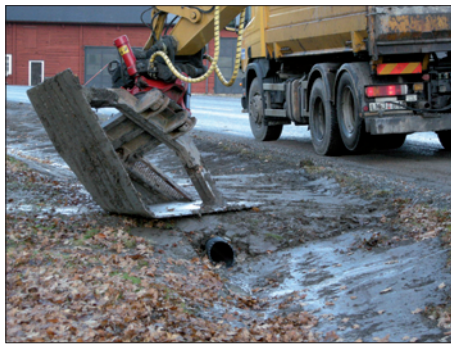
Figur 7 a-b. I vägbanken lades en trumma (20 cm i diameter) i diskret färg. Kanterna fasades av för att bättre smälta in i miljön. Fotograferat från nordväst av Maud Emanuelsson.
