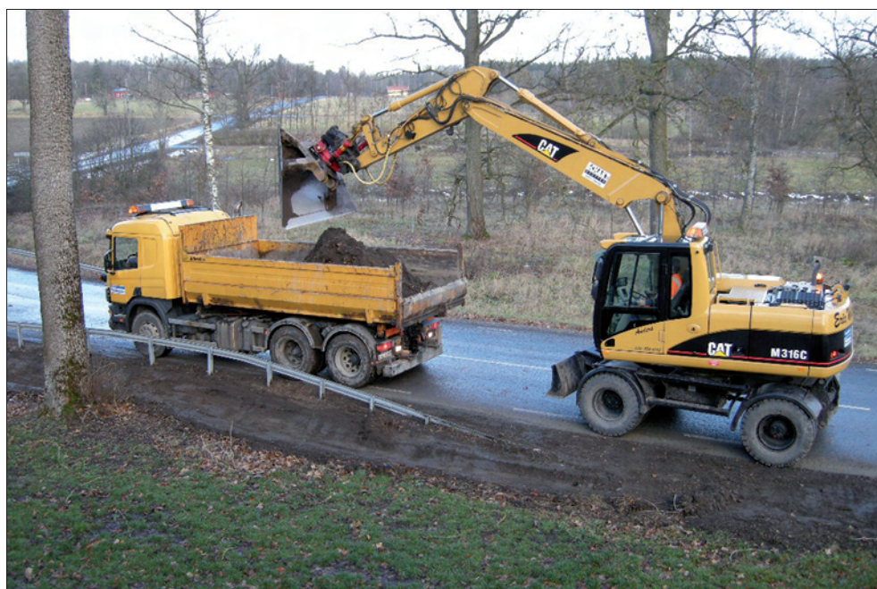
Figur 2. Vägverket Produktion i arbete med att kantskära och dikesrensa. Arbetet utförs i vägsträckans nordligaste del. Fotograf Maud Emanuelsson.
