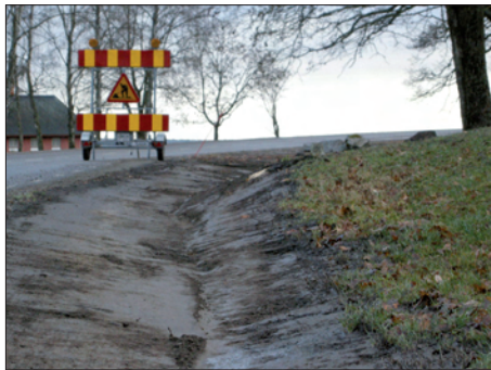
Figur 10 a-b. För att leda regnvatten behövdes ett mindre ingrepp göras, efter samråd med länsstyrelsen, i en naturlig förhöjning i höjd med Hedensbergs huvudbyggnad. Fotograferat från nordväst (a) och sydost (b) av Maud Emanuelsson.
