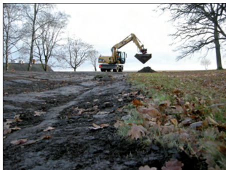
Figur 8. För att leda vattnet till en fungerande brunn krävdes ett visst motlut från parken. Fotograferat från norr vid infarten till förvaltarbostaden. Fotograf Maud Emanuelsson.
