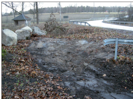
Figur 12 a-b. För att förhindra balka på landsvägen leds regnvatten från landsvägen över en mindre infart. Fotograferat från sydost 8 (a) och öster (b) av Maud Emanuelsson.
