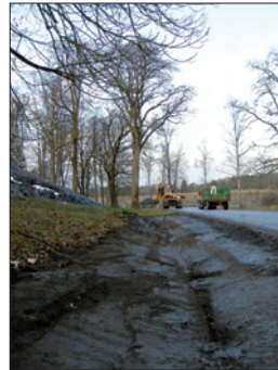
Figur 10 a-b. För att leda regnvatten behövdes ett mindre ingrepp göras, efter samråd med länsstyrelsen, i en naturlig förhöjning i höjd med Hedensbergs huvudbyggnad. Fotograferat från nordväst (a) och sydost (b) av Maud Emanuelsson.
