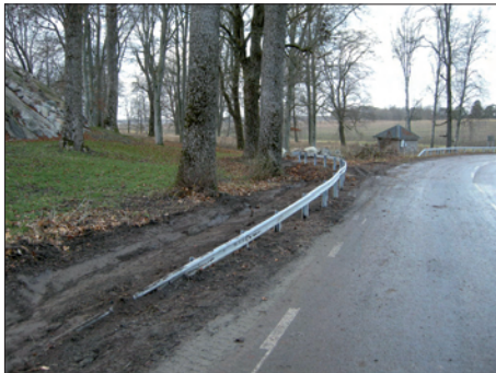
Figur 11. I den nordligaste delen av vägsträckningen fick kantskärningen/dikesrensningen följa samma sträckning som vägräcket. Här kantskar och dikesrensade Vägverket Produktion därför en bit från landsvägen. Fotograferat från sydost av Maud Emanuelsson.
