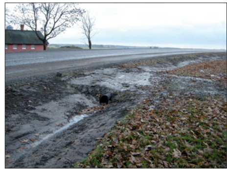
Figur 7 a-b. I vägbanken lades en trumma (20 cm i diameter) i diskret färg. Kanterna fasades av för att bättre smälta in i miljön. Fotograferat från nordväst av Maud Emanuelsson.
