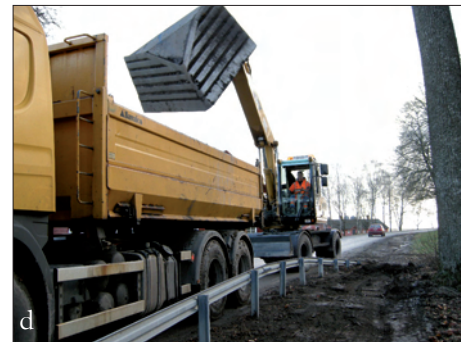
Figur 3 a-d. Arbetet inleddes onsdagen den 26 november. Dagarna före hade det snöat ymnigt (a), vilket till viss del försämrade arbetet. När snön smälte under dag två utfördes arbetet delvis i skymningsljus (b). Inga rötter fick skadas (c). Maskinisten måste därför ta stor hänsyn till parkträden. Alla massor lades på lastbilsflaket (d) och tippades på plats som anvisats av fastighetsägaren. Notera även den specialbyggda släntskopian (d). Fotograferat av Maud Emanuelsson.
