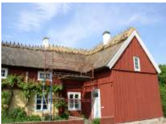
Södra takfallet samt vinkelbyggnaden.
