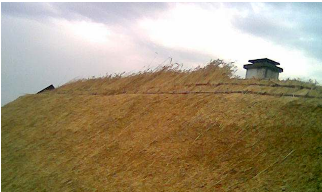
Norra takfallet innan omryggning. Notera hasselrafterna.
