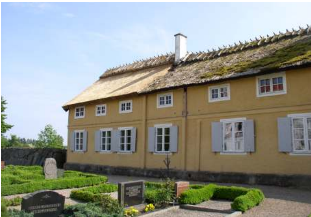
Norra takfallet, östra delen, efter omtäckning.
