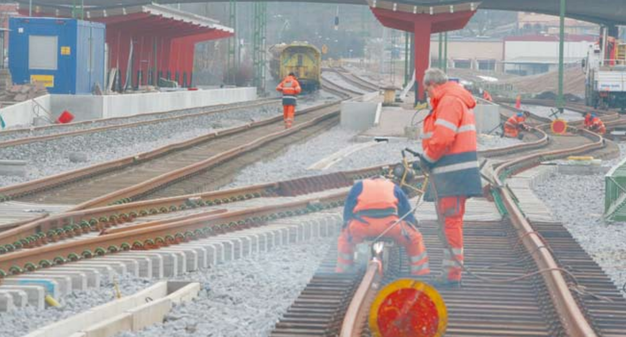
Ronneby är en av de bangårdar som rustas upp i samband med elektrifieringen. Foto: Ingemar Elofsson
