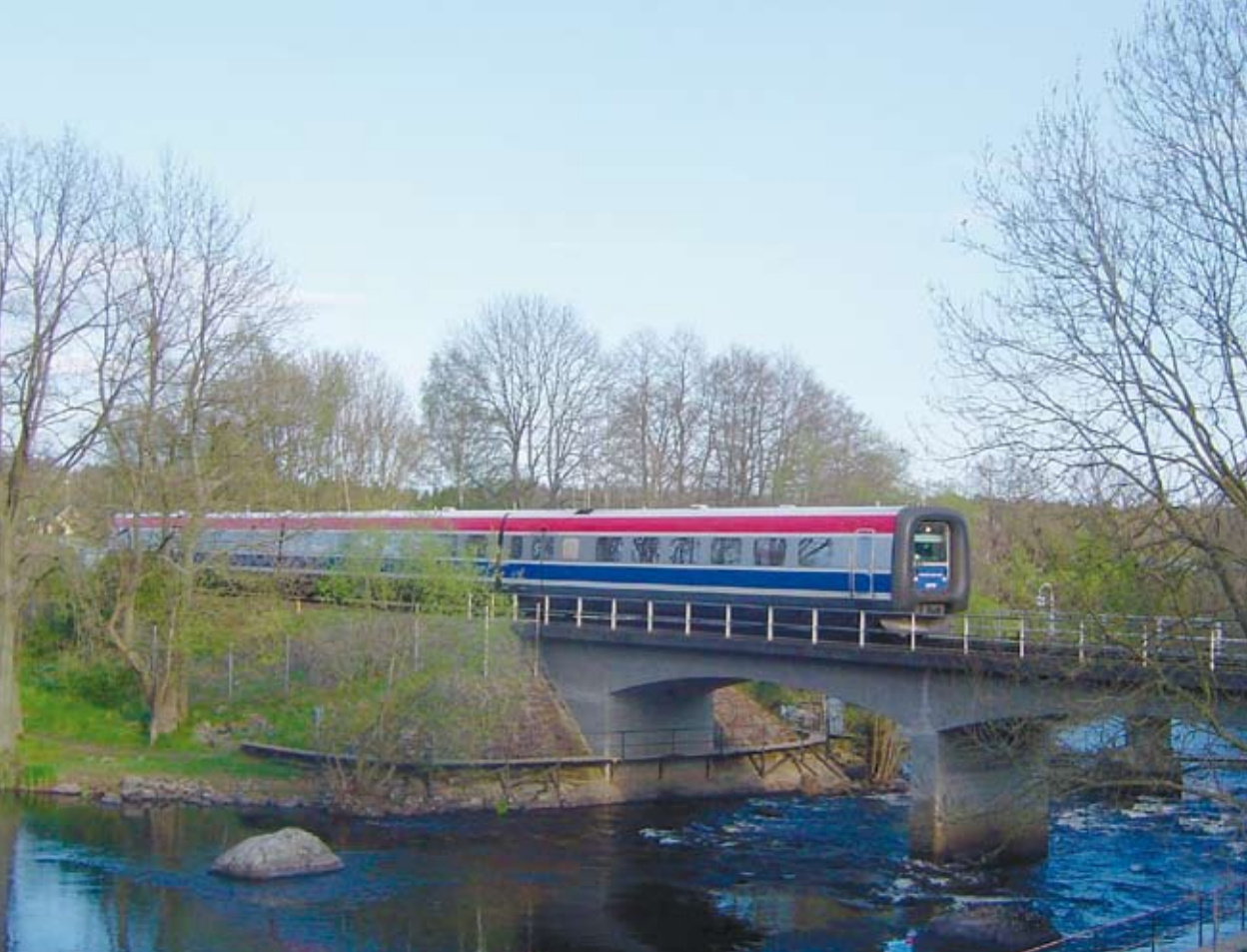
Kustpilen på bron över Mörrumsån. Bron byggdes i samband med breddningen på 1950-talet. Foto: Mats Folkesson
