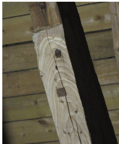
BILD 18. I både Söderby Karl och Tensta kyrkor konfirmerade man många av sammanhuggningarna med både spik och tränagel, på bilden ser vi övergången från ett krumvirke till saxsparre. Foto Robert Carlsson.
