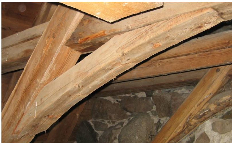
BILD 11. På bilden ser vi en ovanlig situation, man har tagit en sparre eller bjälke och givit den önskad radie, alltså ett rakt ämne. Som synes krävdes då att ämnet hade en grov dimension, dels för att fylla radien men även för att inte bli försvagat. Foto Robert Carlsson.
