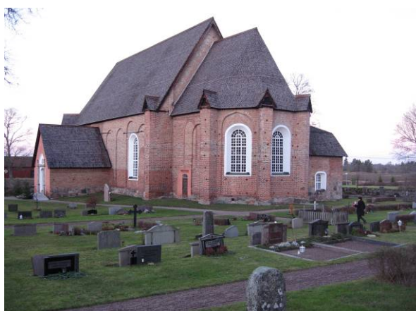
BILD 13. Tensta kyrka in situ. Som synes följer korets takform dess grundplan, vilket innebär ett komplext taklag. Foto Robert Carlsson.
