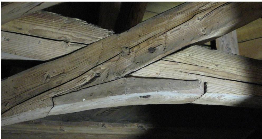
BILD 15. Saxsparre möter hanbjälke, vecket var utfyllt och förstyvat med en spikad löt eller kloss. Lägg även märke till fasningen på undersidan av hanbjälken som fullföljde valvets radie. I flera fall hade sammanhuggningen och fasningen inneburit en allvarlig försvagning av takstolen, ibland med materialbrott som följd. Situationen på bilden utgör dock ingen grund för oro. Foto Robert Carlsson.
