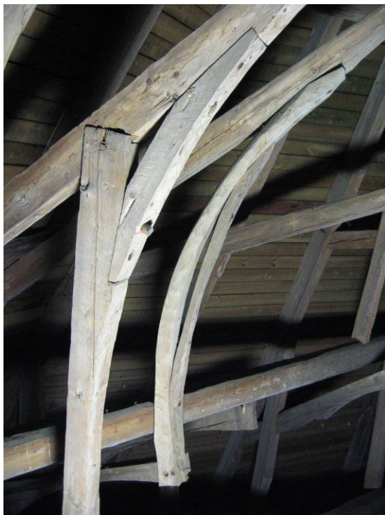
BILD 17. Förutom den vanliga varianten av mer eller mindre naturvuxet krumvirke i ett stycke, kan man bland annat finna kombinationer av raka virken som lötats samman och formats till en radie eller till och med krumvirken som lagts samman till rätta radien. Foto Robert Carlsson.
