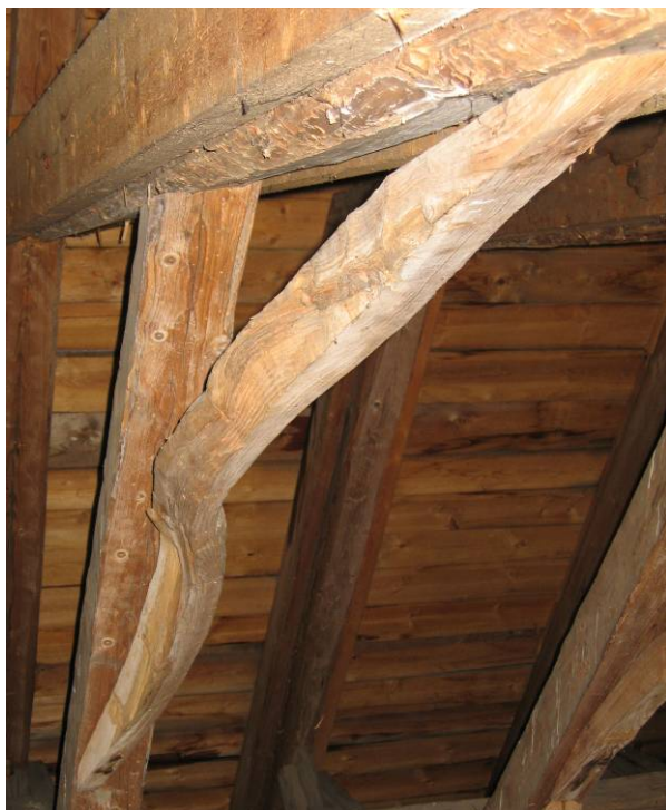
BILD 4. Man tvekade inte när man genom klyvning framställde denna krokiga krum, ämnet fick ju till slut den radie som krävdes på byggsidan, medan flankerande virkessidor lämnades med den slängkrök råvaran bjöd. Krumvirket verkar innehålla rotved. Foto Robert Carlsson.
