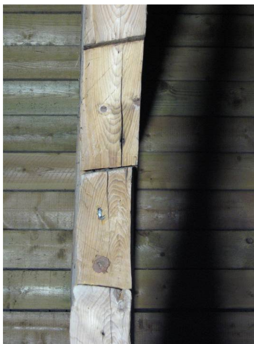
BILD 15. Saxsparre möter hanbjälke, vecket var utfyllt och förstyvat med en spikad löt eller kloss. Lägg även märke till fasningen på undersidan av hanbjälken som fullföljde valvets radie. I flera fall hade sammanhuggningen och fasningen inneburit en allvarlig försvagning av takstolen, ibland med materialbrott som följd. Situationen på bilden utgör dock ingen grund för oro. Foto Robert Carlsson.
