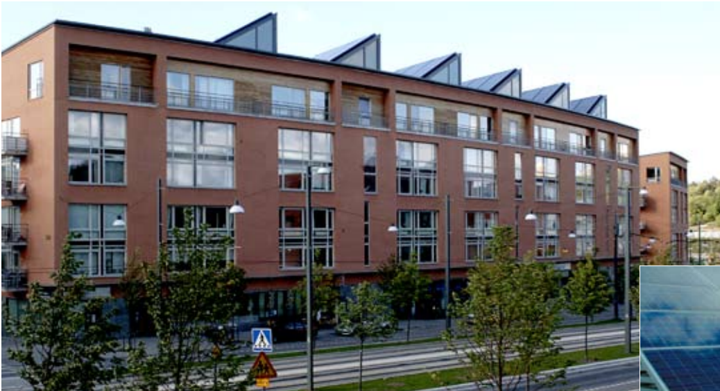
Solfångare. På många tak finns solfångare som tar vara på solvärmens och utnyttjar den till uppvärmning av varmvatten. Solfångarna på bilden räcker till hälften av husets årliga varmvattenbehov.
