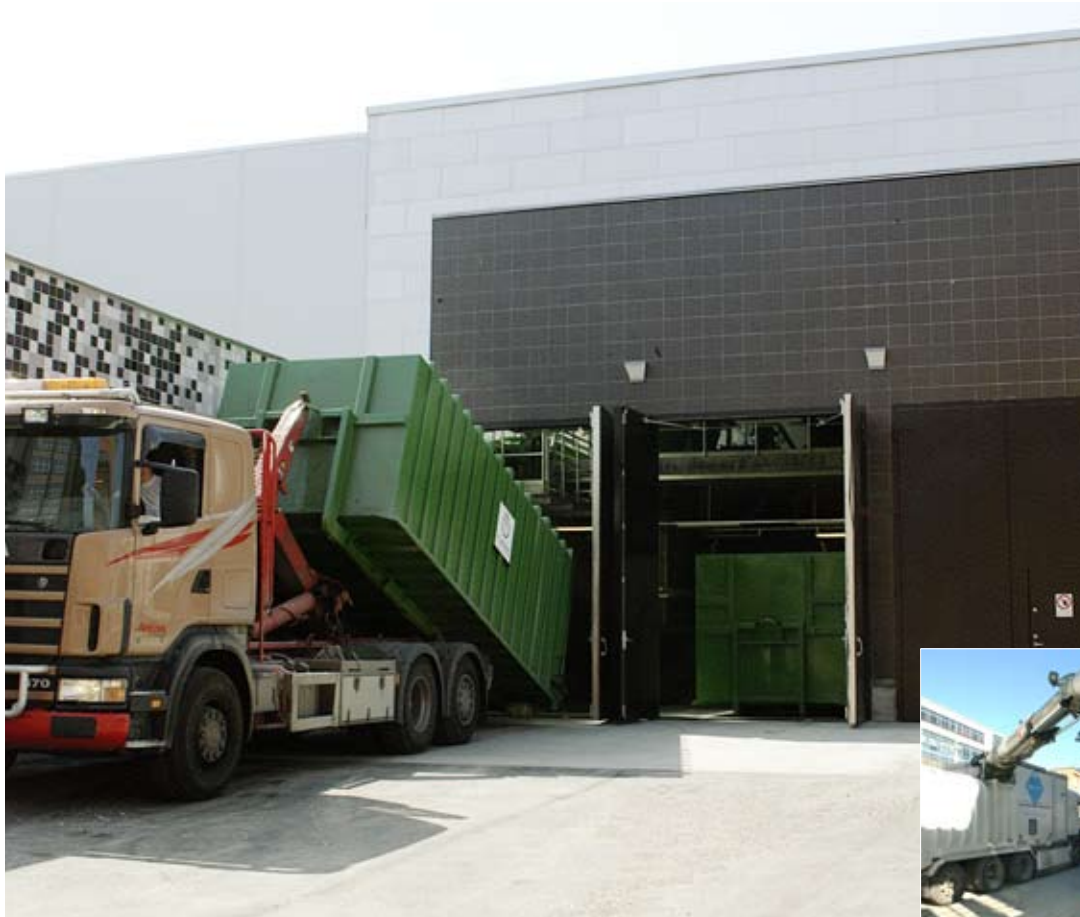
Hämtning av en avfallsfraktion vid den centrala uppsamlingsstationen för det stationära sopsugssystemet vid Mårtensdal i Hammarby Sjöstad.
