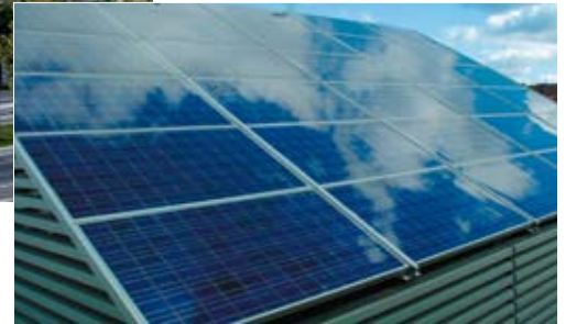
Solceller. Solens ljusenergi fångas upp och omvandlas i solceller till elenergi. Energin från en solcellsmodul på en kvadratmeter ger cirka 100 kWh/år vilket motsvarar hushållsel för tre kvadratmeter bostadsyta.
