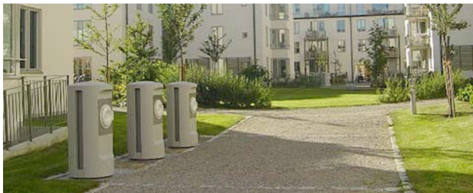
Sopbil med vakuumsug vid en av dockningspunkterna för det mobila sopsugsystemet.
