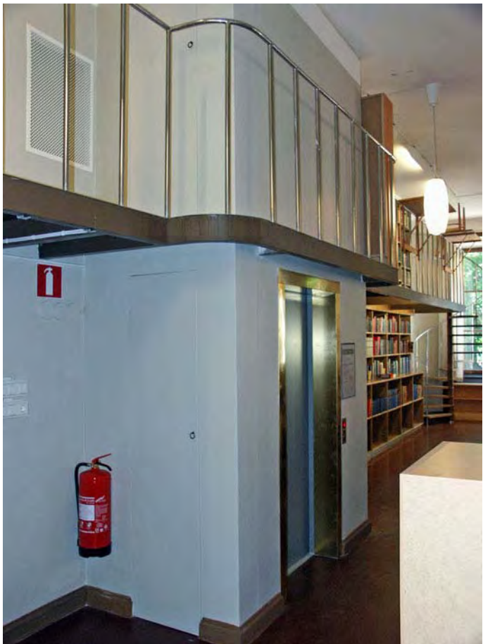
Här ses läsesal B och hissen före (ovan) och efter (nedan) ombyggnaden.
