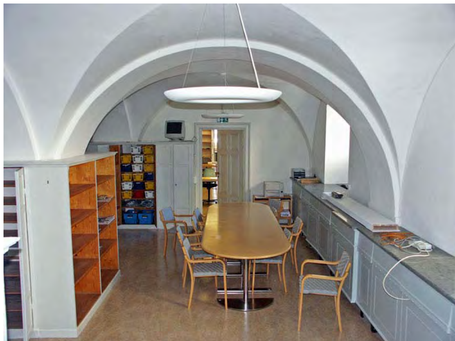
Bild från plan 5 där kart- och bildavdelningen tidigare fanns. Den gamla skåp- och hyllinredningen från 1917 har sparats. Till höger ses ny bröstpanel täckt av marmorskivor som döljer ventilationsrör mm.
