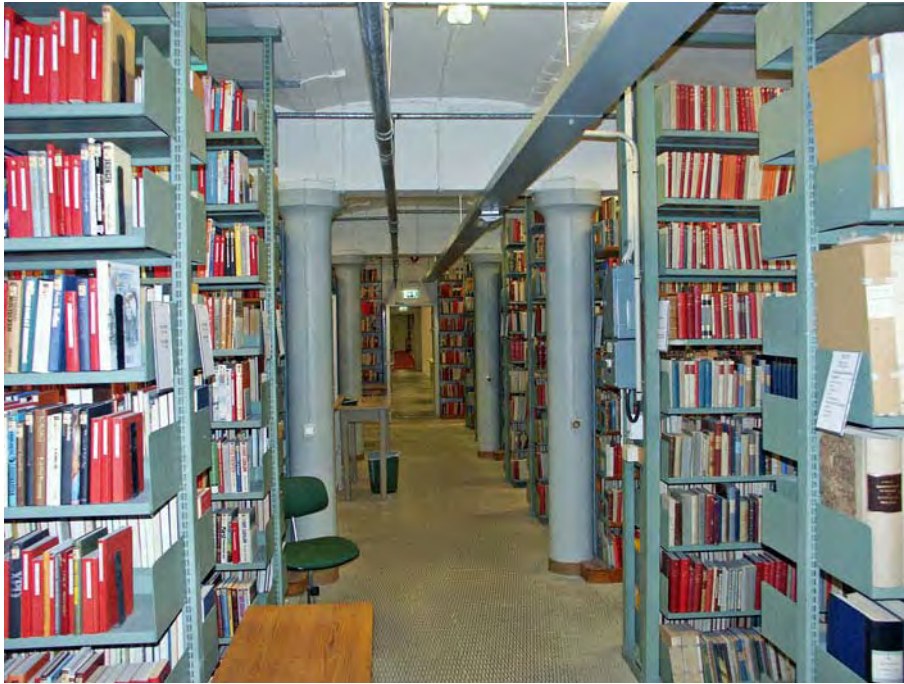
Här ses hur nya kabelrännor hängts under tak i ett av bokmagasinen.
