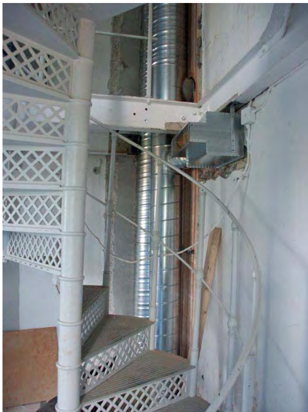
Nya ventilationskanaler i hörnrum under ombyggnadstiden. I de gamla ventilationsschakten kunde äldre färglager i limfärg dokumenteras.
