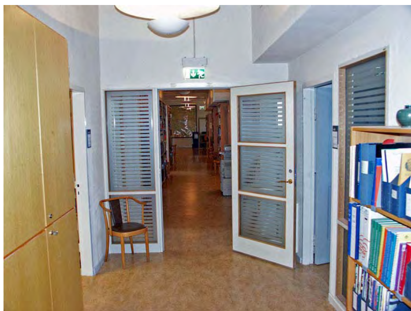
Nya brandglasdörrar vid kontorsutrymmen.
