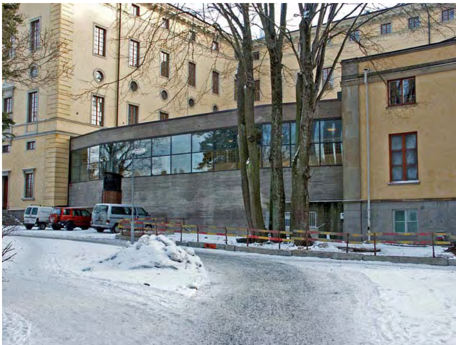
På bilden ses läsesalen som uppfördes efter Peter Celsings ritningar på 1960-talet. Utanför salen har en ny ventilationsskorsten placerats. Bakom träden skymtar den nya utrymningsvägen från plan 3.
