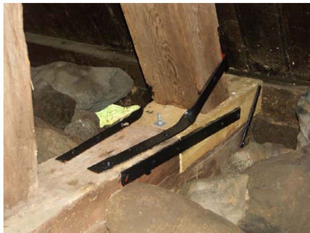
Snedsträva förankrad i bottenstocken, punkt A
