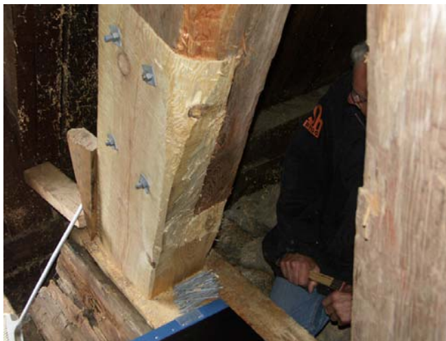
Ilagning av snedsträva tv innanför ingången
