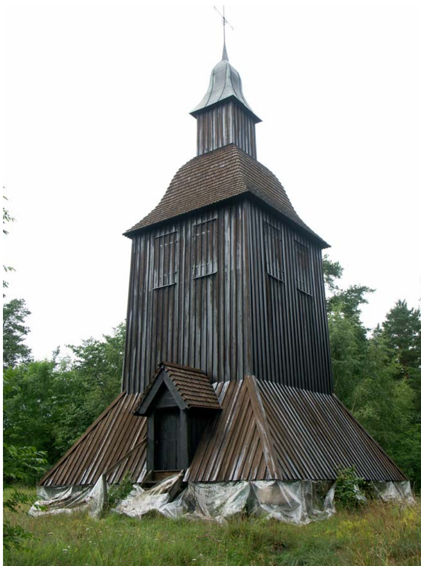
Slutförd tjärning av klockstapeln 2007
