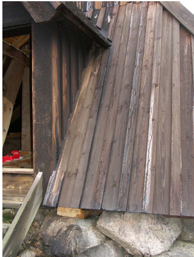
Utbytt bottenstock före tjärstrykning
