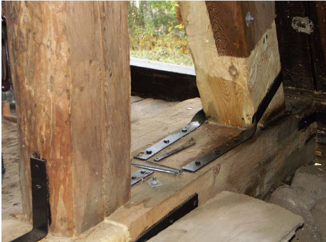
Snedsträva förankrad med gördel i bottenstock
