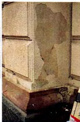
Detalj av sockel och puts. Under plastfärgen finna ursprunglig kalkfärg.
