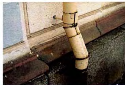
Detalj av sockel och puts. Under plastfärgen finna ursprunglig kalkfärg.
